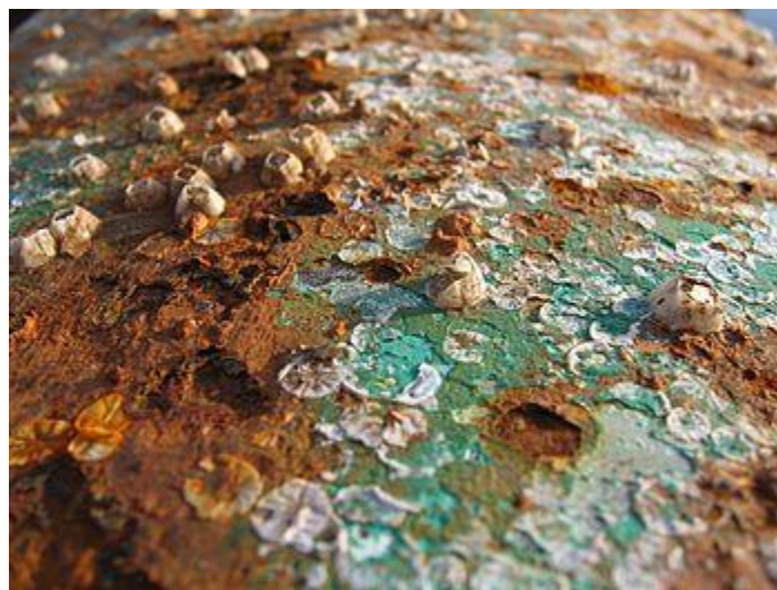
Figura 23: efectos de la corrosión por microorganismos. Fuente: (23)
