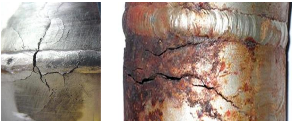
Figura 16: Ejemplo de corrosión bajo tensión. Fuente: (16)
