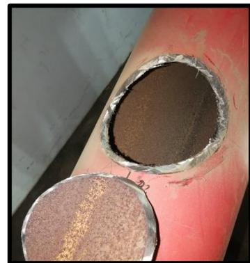
Ilustración n°69: Corte en colector
