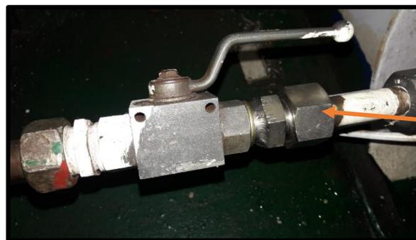
Ilustración n°83: Acople colocado
