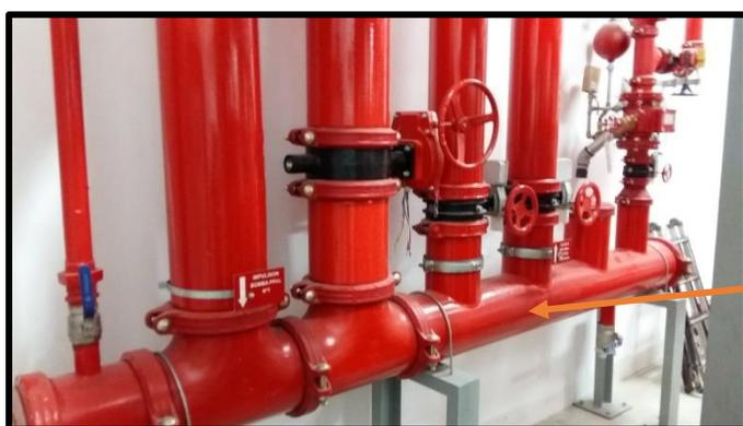
Ilustración n°71: Colector terminado
