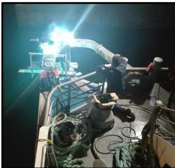
Ilustración n°92: Soldando el fender
