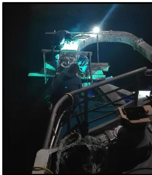
Ilustración n°91: Soldadura fender
