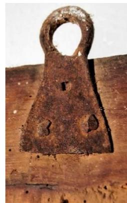
*Figura 51.- Sistema de enganche del marco, se aprecia claramente su estado de oxidación y que le falta uno de los clavos.*
