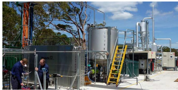
Figura 16. Prototipo de la planta de reciclaje químico de plásticos en Somersby (en la Costa Central de Nueva Gales del Sur, Australia). [XVI]
