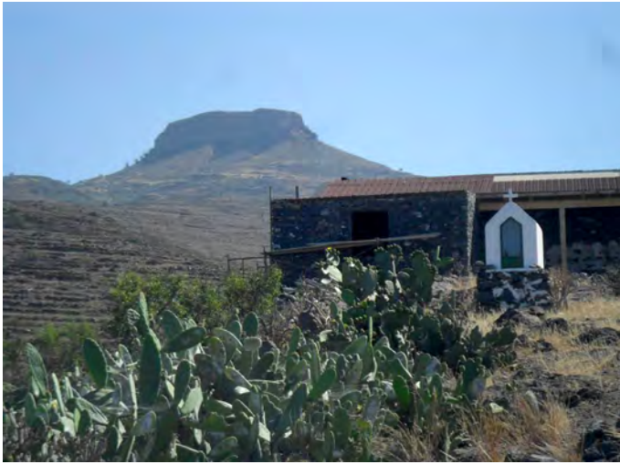
Fig. 2. Nicho vacío en el lugar de Santa Catalina, municipio de Vallehermoso, La Gomera.
