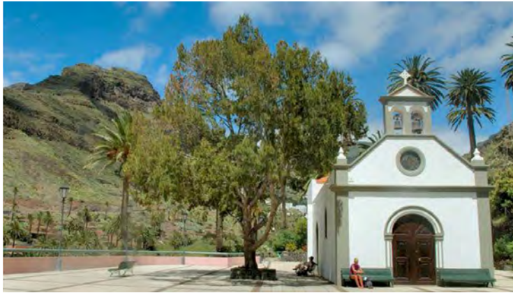
Fig. 3. Estado actual de la ermita de los Santos Reyes, en Valle Gran Rey, La Gomera.
