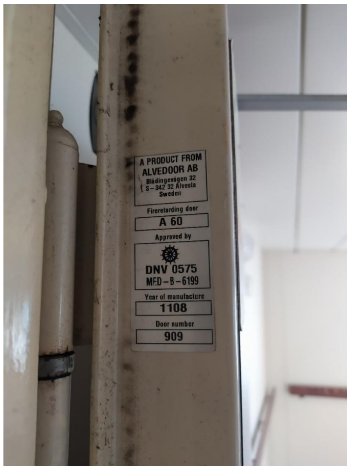
Imagen 31. Especificaciones puerta contra incendios A-60. Fuente: Elaboración propia.
