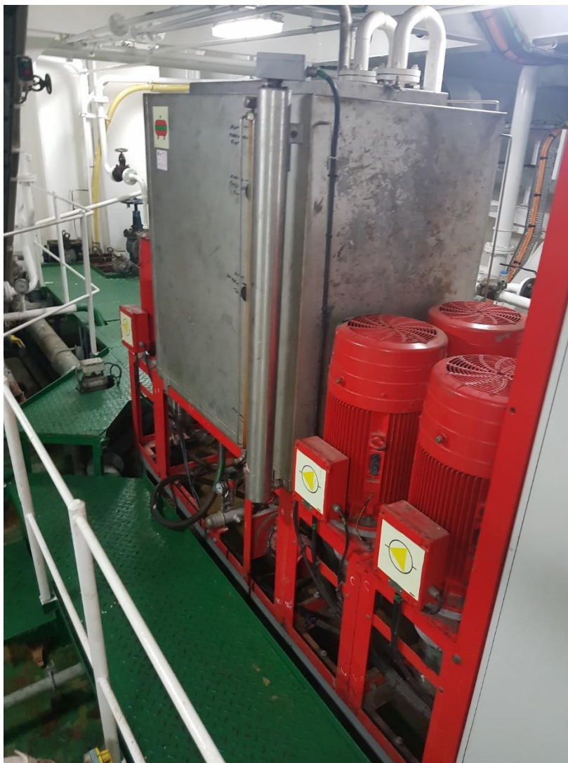
Imagen 3. Bombas y tanque de agua dulce del sistema. Fuente: Elaboración propia.
