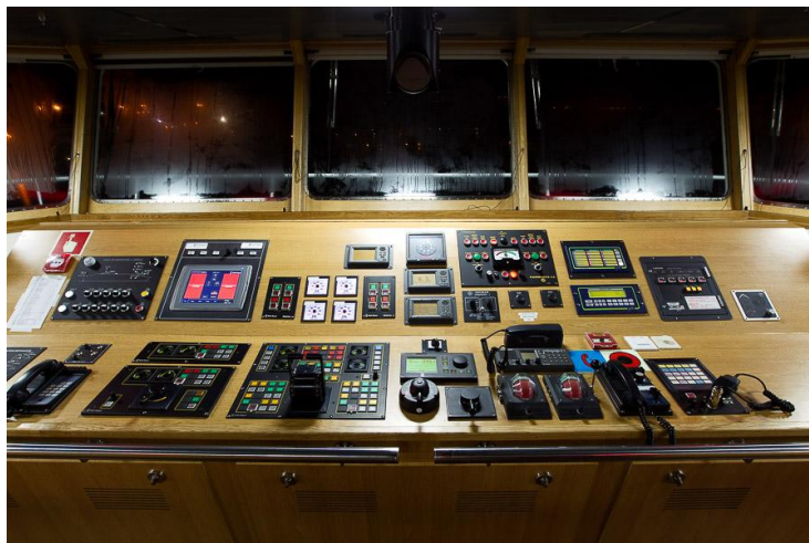
Figura 29. Consola central del puente del buque Volcán del Teide. Fuente: [10].
