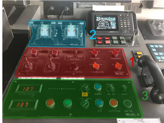
Figura 14. Estación principal de control. Fuente: Trabajo de campo.
