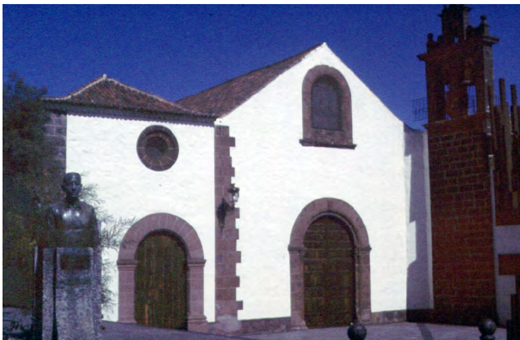
Fig. 1. Fachada principal de la iglesia de Sto. Domingo de La Laguna.
