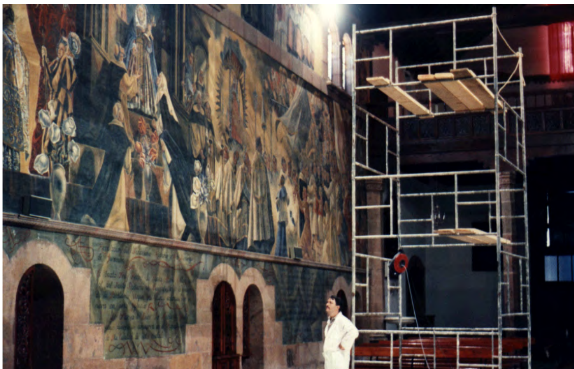
Fig. 29. Instalación de andamio frente al mural
