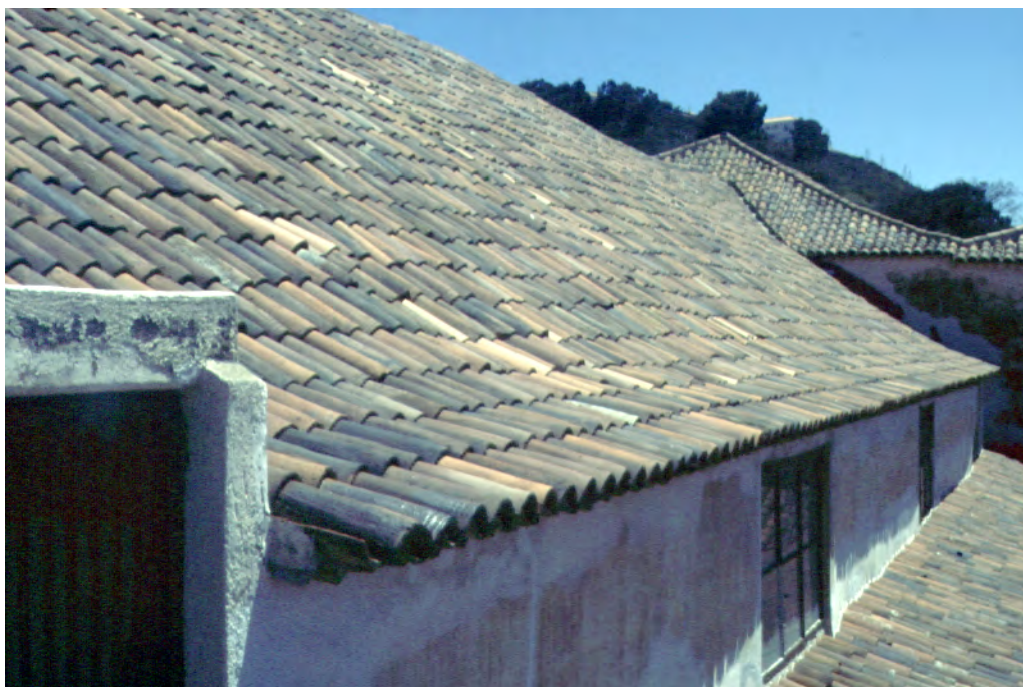
Fig. 5. Muro exterior derecho.
