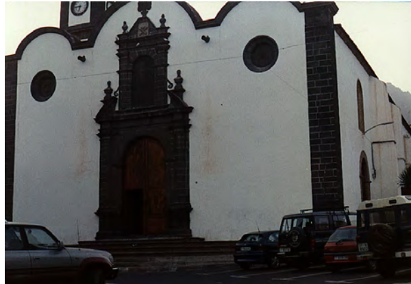
Fig. 1. Fotografía del exterior de la iglesia S. Pedro (Güímar).
