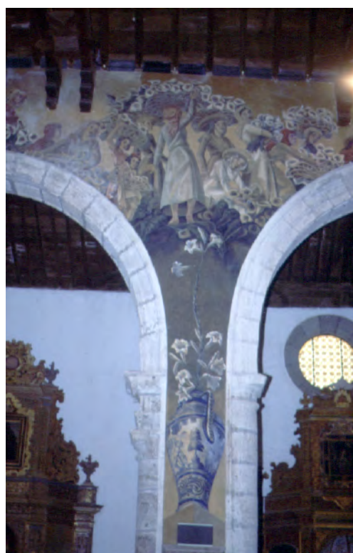
Fig. 12. Mural a la izquierda de la nave central, 2º.
