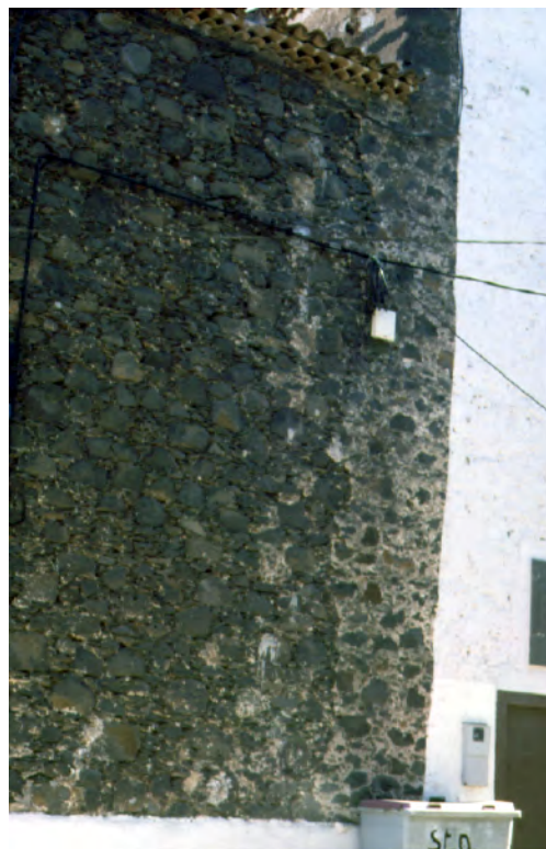
Fig. 4. Detalle del muro exterior izquierda.
