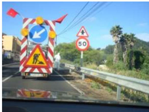
Fig.1.23. Máquina de tratamiento y aplicador de fitosanitarios tratando de mala hierbas en bordes de carretera
