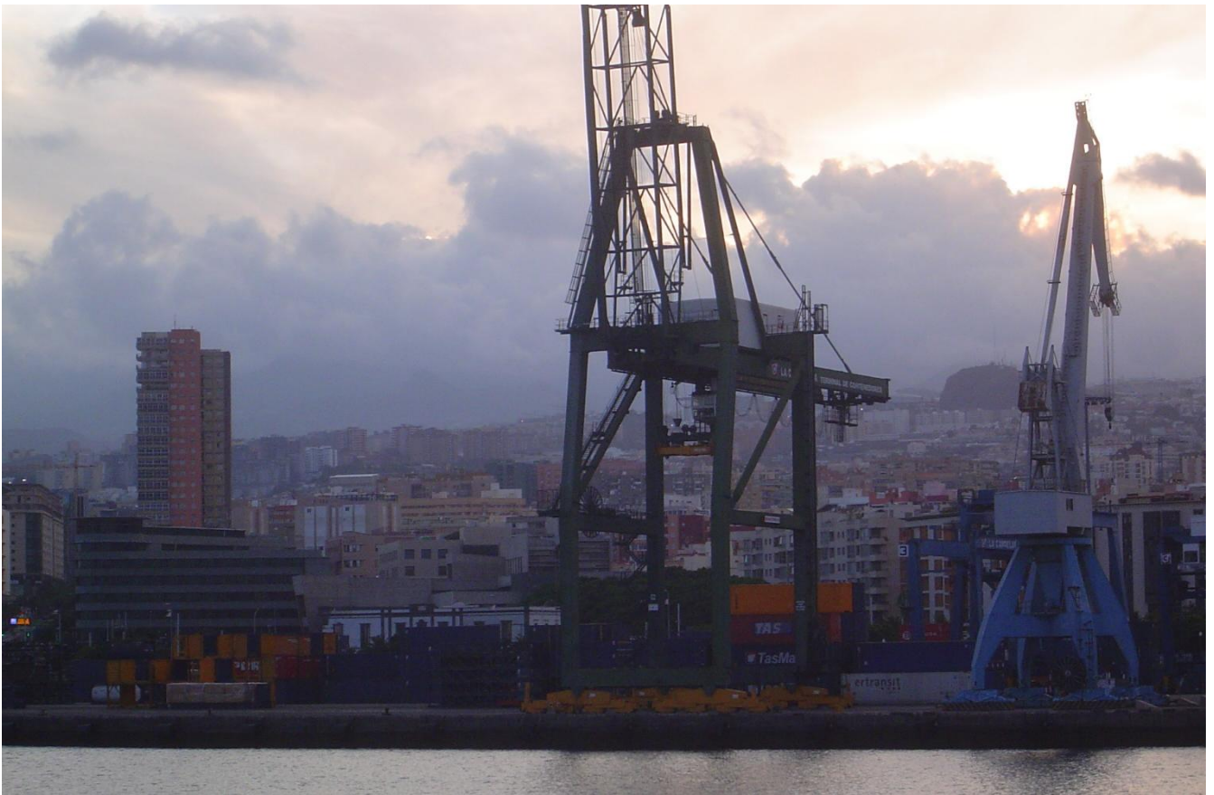
Dársena de Los Llanos en su tramo Sur, detrás el barrio de El Cabo. Fotografía realizada por Alejandro Armas.
