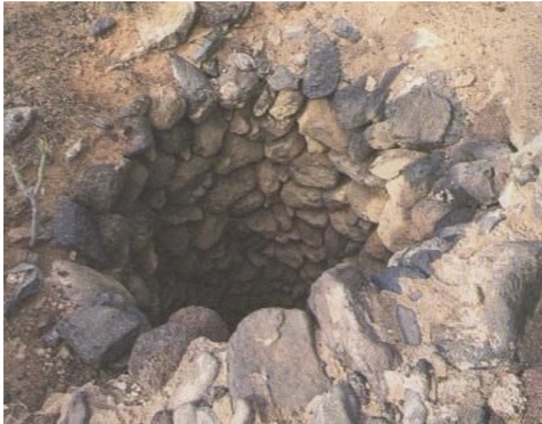
Figura 3.3.1.6. Pozo vivienda de referencia
