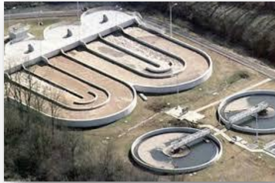
Ilustración 5.20. Vista aérea de un proceso de fangos activados con canales de oxidación. (Fuente: Química, 2020)
