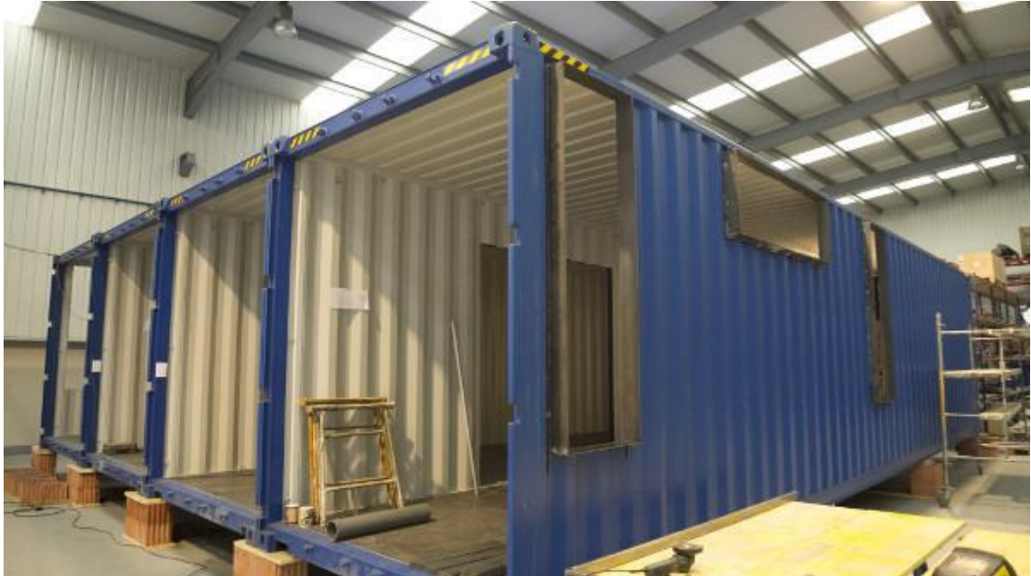
Ilustración 6. Unión, reparación y apertura de huecos. Fuente: Google Images
