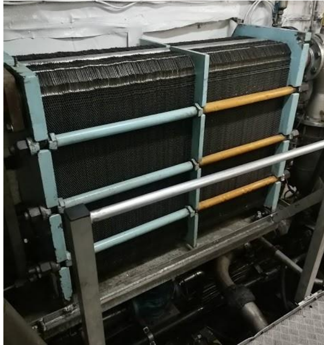
Ilustración 7:Enfriador Aceite - Agua
