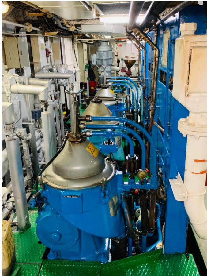
Ilustración 26: Depuradoras de aceite
