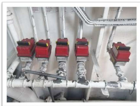
Ilustración 57 VÁLVULAS DE LAS SECCIONES DEL MINIFOG
