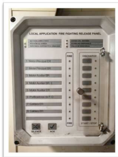
Ilustración 55 PANEL DE DISPARO DEL MINIFOG
