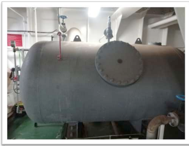
Ilustración 42 TANQUE HIDRÓFORO
