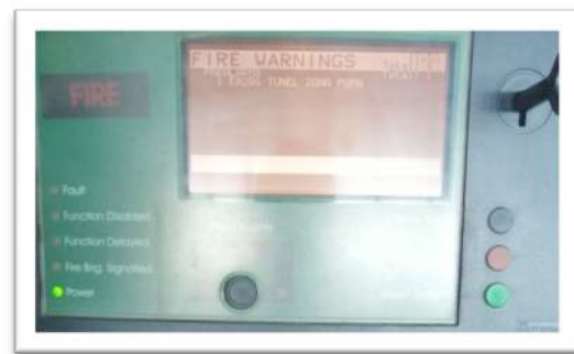
Ilustración 14 PANTALLA DE CABINET AUTRÓNICA
