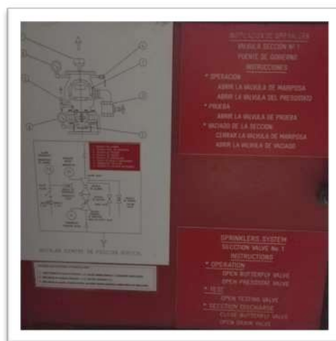
Ilustración 45 INSTRUCCIONES DE LA SECCIÓN SPRINKLER
