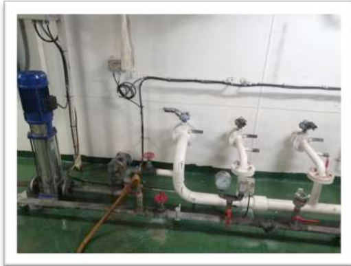
Ilustración 60 BOMBA MINIFOG
