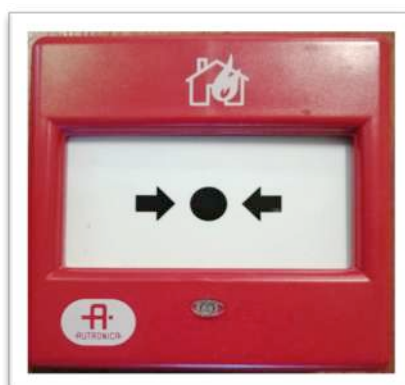
Ilustración 17 PULSADOR DE ALARMA
