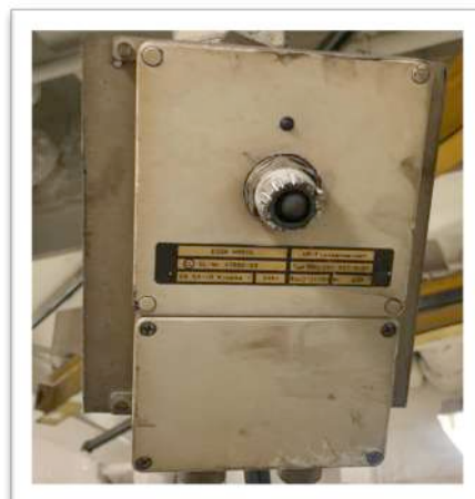
Ilustración 23 DETECTOR DE LLAMA M.P
