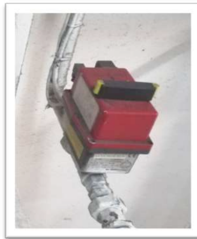
Ilustración 61 VÁLVULA DE SECCIÓN MINIFOG
