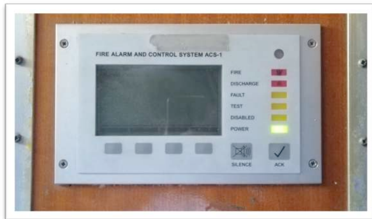
Ilustración 56 PANEL INFORMATIVO DEL MINIFOG
