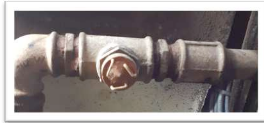
Ilustración 59 DIFUSOR DEL SISTEMA MINIFOG
