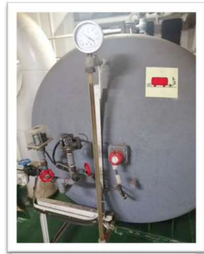
Ilustración 43 TANQUE HIDRÓFORO
