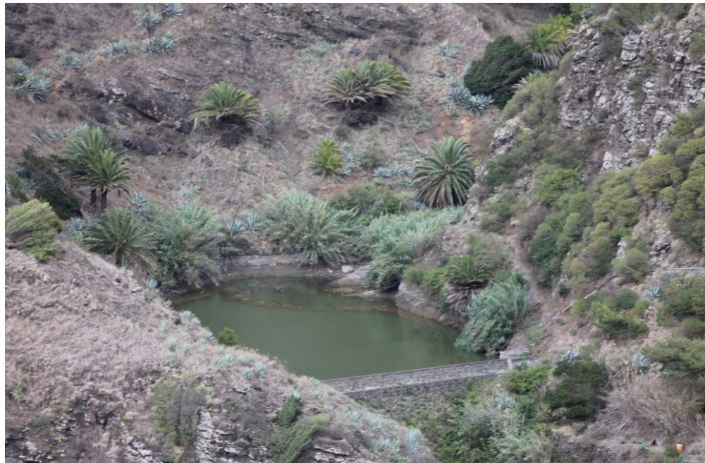
Figura 11.6. Presa encajada en un barrando en la isla de La Gomera para riego agrícola
