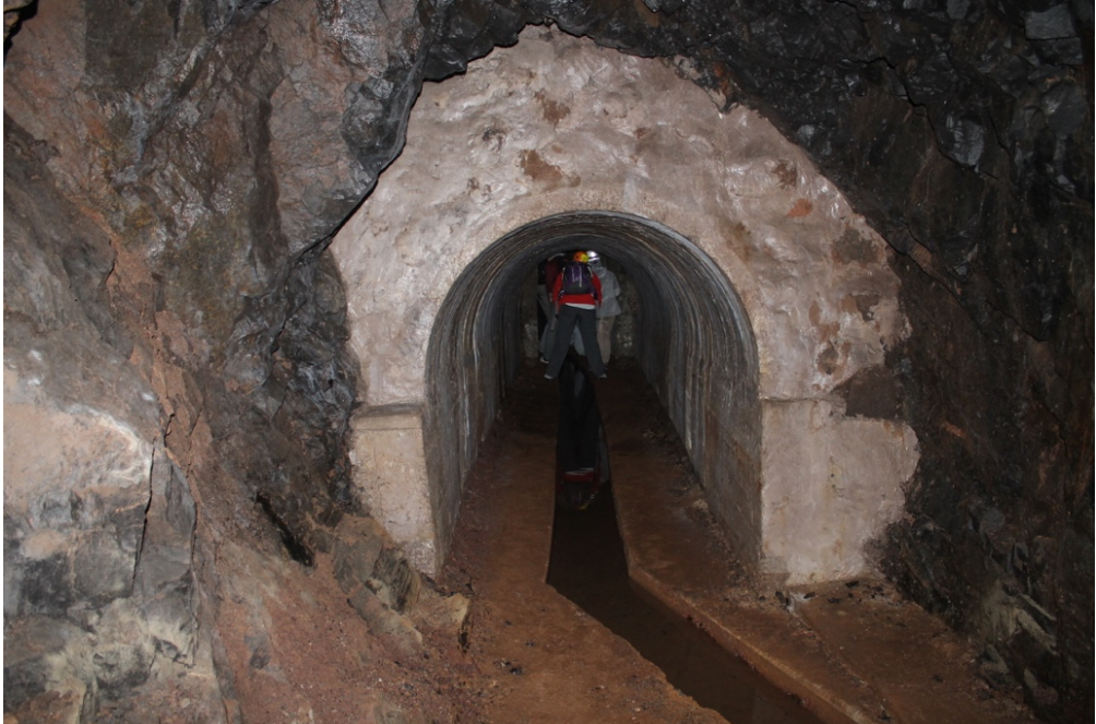
Figura 12.4. Sección de galería (mina) de agua en la isla de Tenerife
