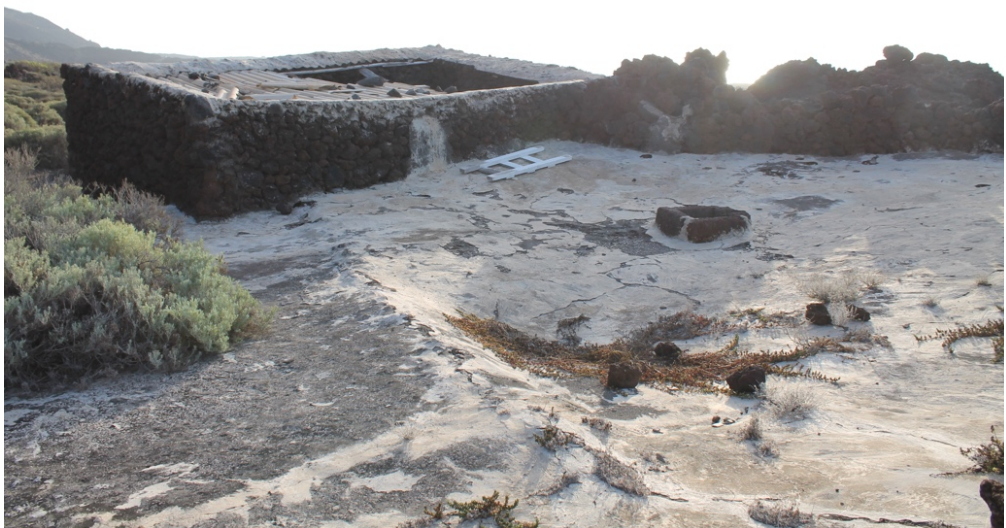
Figura 11.3. Mareta y aljibe, para el aprovechamiento del agua de lluvia en la isla de El Hierro
