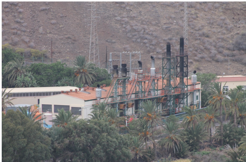
Figura 12.13. Central eléctrica diésel en la isla de Gomera
