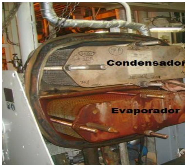
*Ilustración 12. Interior de un evaporador. Fuente: (Interior-
