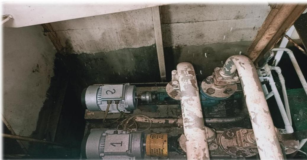
*Ilustración 21. Bombas de alimentación de calderas. Fuente: Trabajo de campo.*
