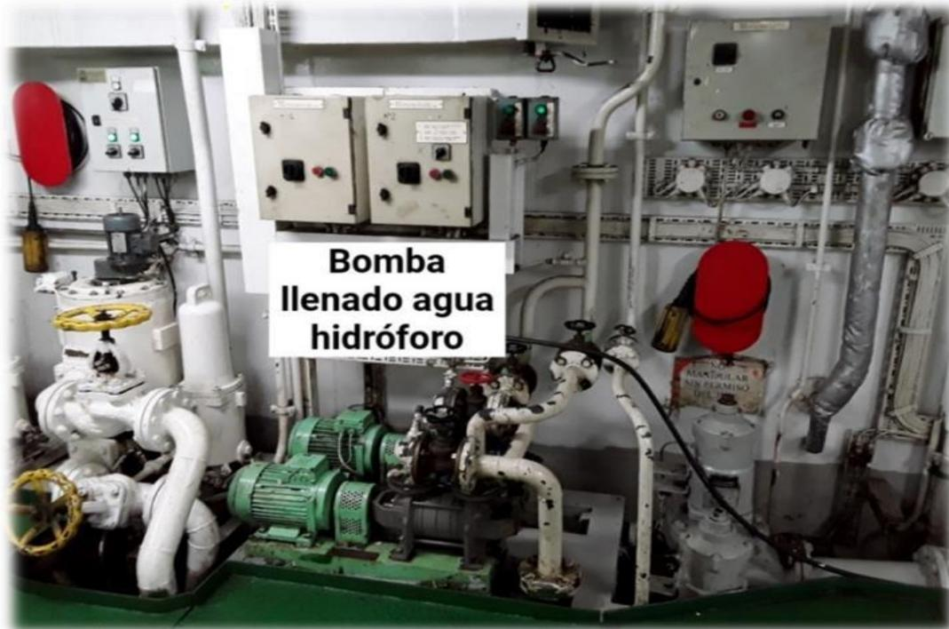
*Ilustración 17. Bomba de agua técnica. Fuente: Trabajo de campo.*
