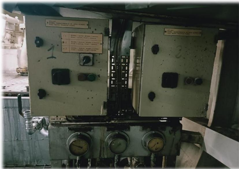
*Ilustración 20. Cuadro eléctrico. Bombas calderas. Fuente: Trabajo de campo.*
