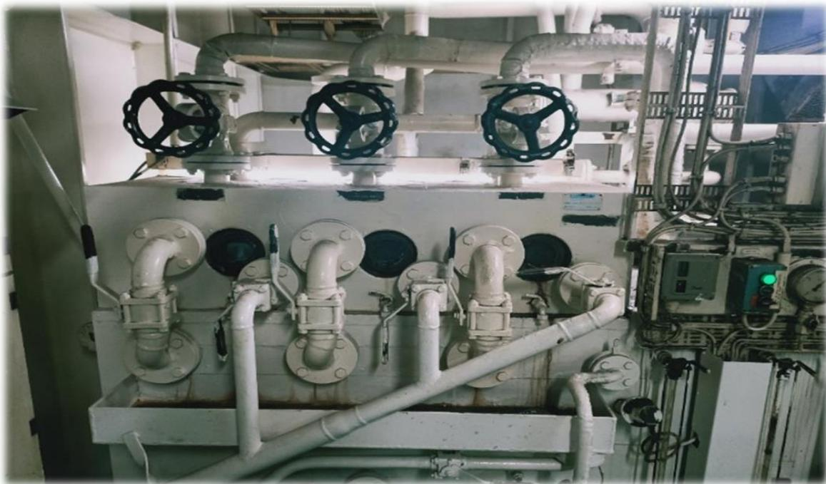
*Ilustración 19. Visores- Cisterna. Fuente: Trabajo de campo.*
