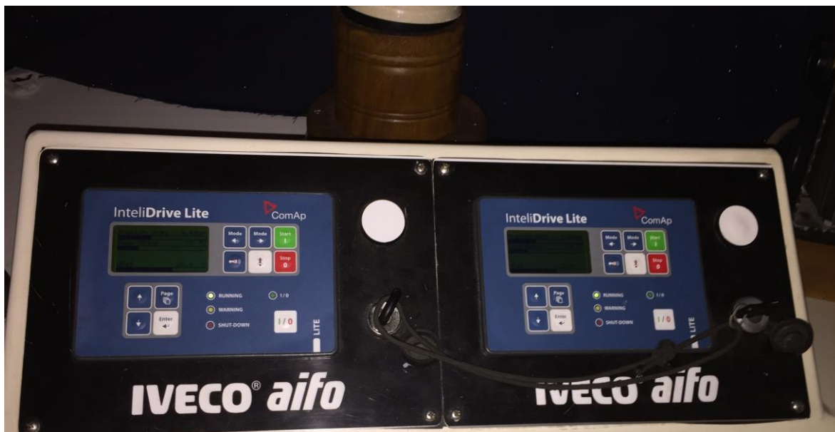
Ilustración 21: Cuadros de arranque
