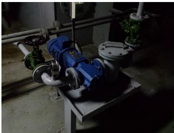
Ilustración [51] bomba de circulación de aceite
