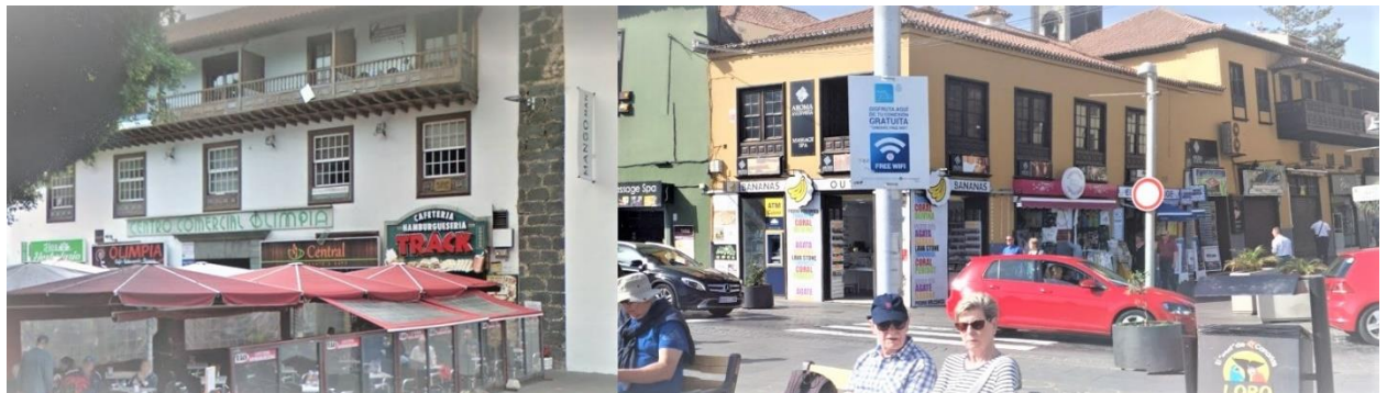
124. DOS EJEMPLOS DE EDIFICACIONES SATURADAS DE CARTELES COMERCIALES (ARCHIVO PERSONAL).
