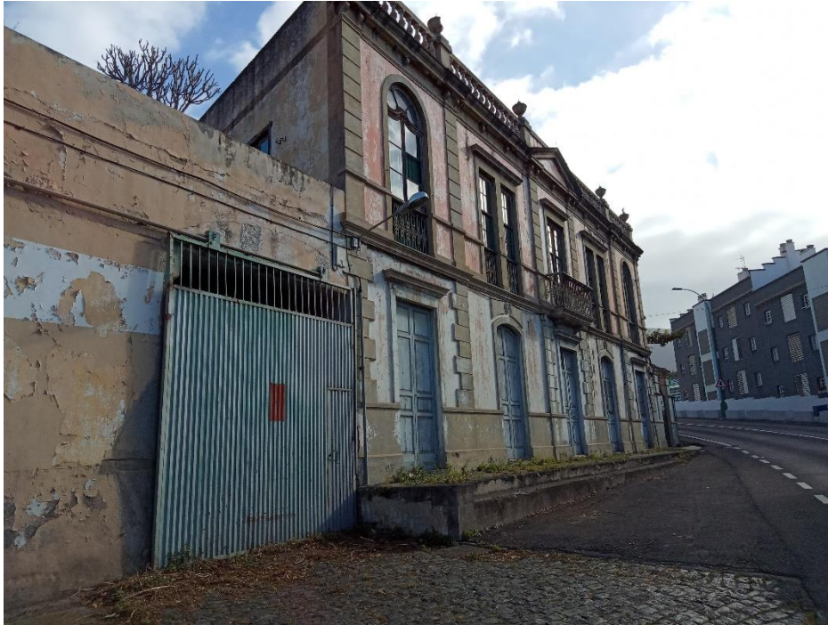
121. FACHADA DEL CONJUNTO (ARCHIVO PERSONAL).
