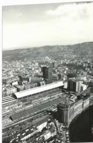
VISTA HACIA EL DESTI DE BILBAO QUE MUESTRA LA ESTACIÓN DEL FERROCARRIL, ESTACIÓN DE PORTUGALETE, JUNTO AL PUENTE DEL ARENAL. VIEW LOOKING WEST OVER BILBAO SHOWING THE TRAIN STATION, ESTACION DE PORTUGALETE, NEAR PUENTE DEL ARENAL.
