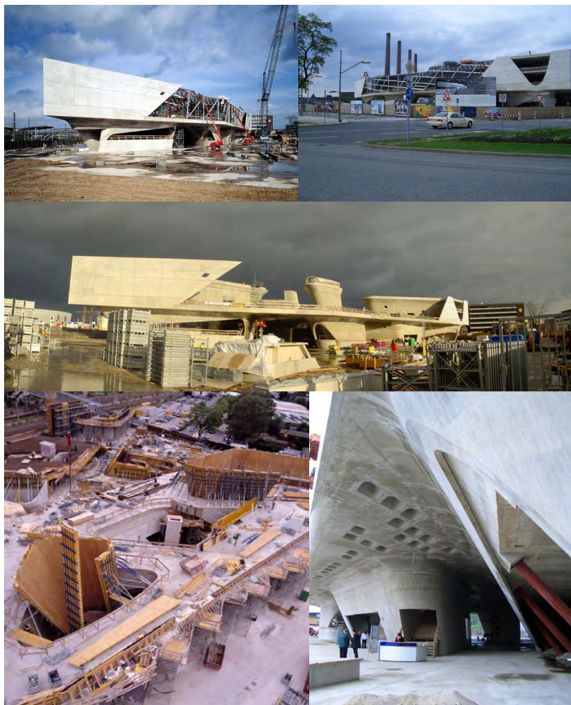
Figs. 10-15. Fotografías de la construcción del edificio.
