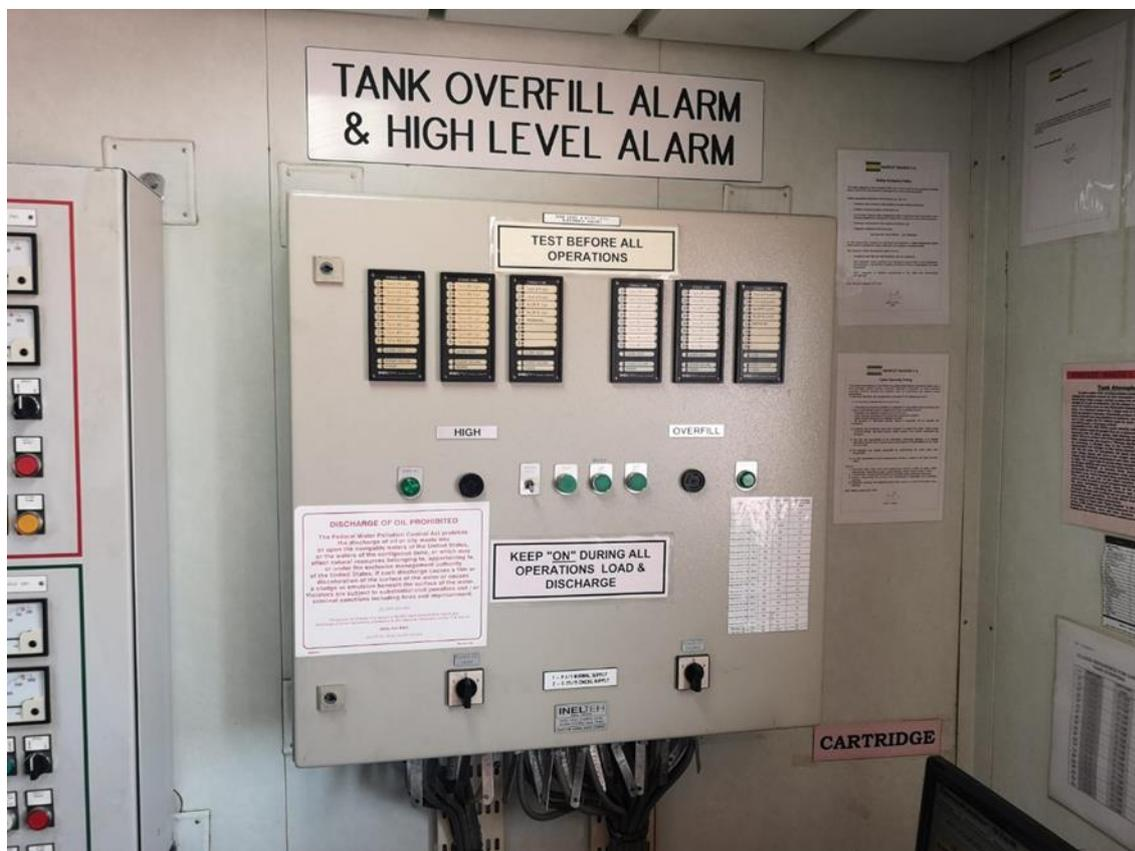
Ilustración 29: imagen del panel de control del hi-level y overfill. Fuente: archivos de Pablo Ballesteros.
