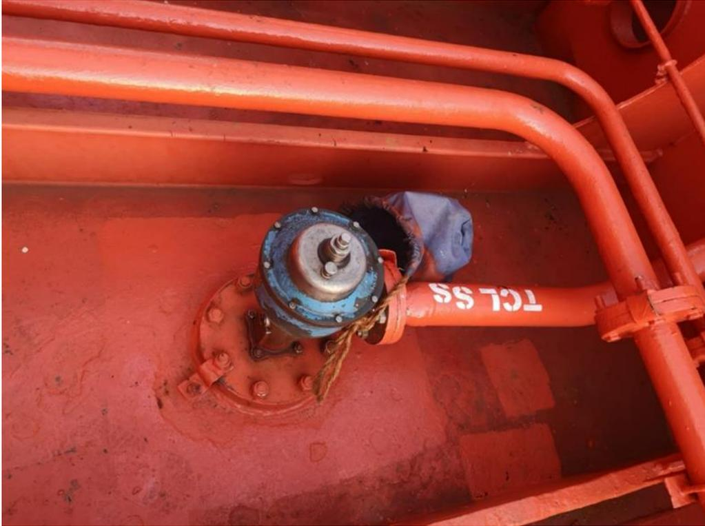
*Ilustración 36: máquina de lavado del Slop de estribor. Fuente: archivos Pablo Ballesteros.*
