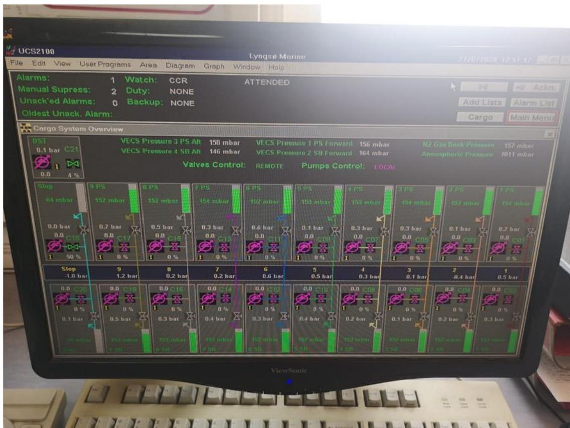
Ilustración 27. imagen del monitor de las bombas de descarga. Fuente: archivos Pablo Ballesteros.
