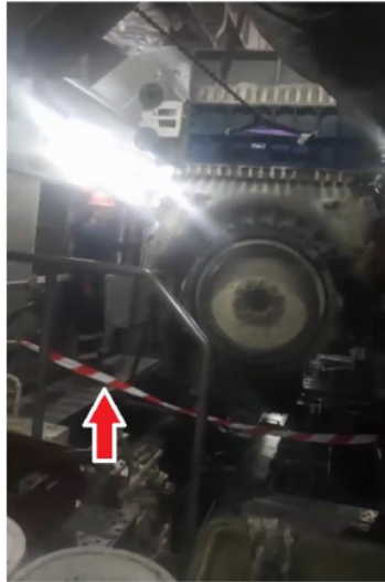
Ilustración 25: cinta de balizamiento perimetral (sala de máquinas)
