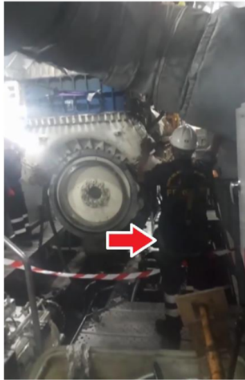
Ilustración 35: maniobra de extracción del motor principal (sala de máquinas)
