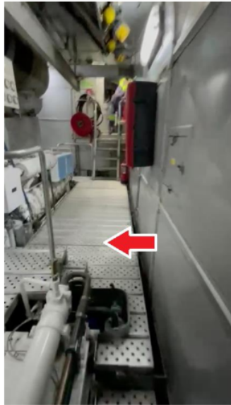
Ilustración 28: pasarela de la sala de máquinas
