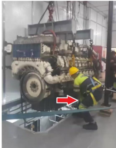
Ilustración 34: extracción del motor principal de la sala de máquinas
