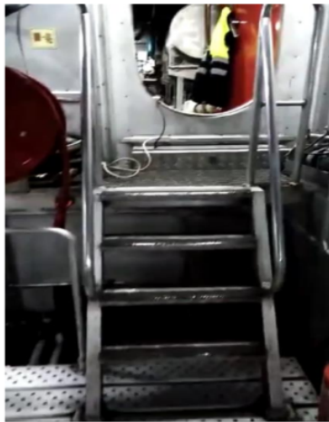
Ilustración 29: escalera de la sala de máquinas
