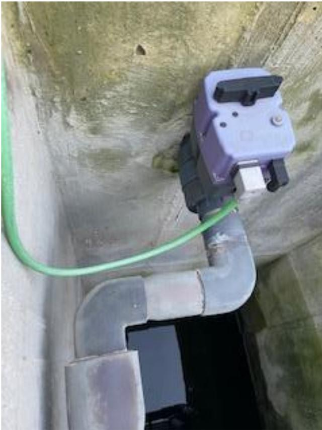
[11] Electroválvula salida del depósito del reactor biológico, fuente elaboración propia.
