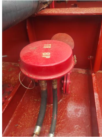
Ilustración 21. Radar de un tanque de carga. Fuente: Trabajo de campo.
