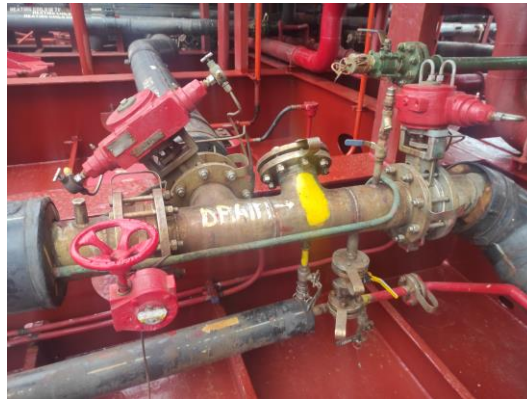
Ilustración 7. Línea de carga junto a las dos válvulas pilotadas y la intermedia. La línea verde es la de acompañamiento. Fuente: Trabajo de campo.
