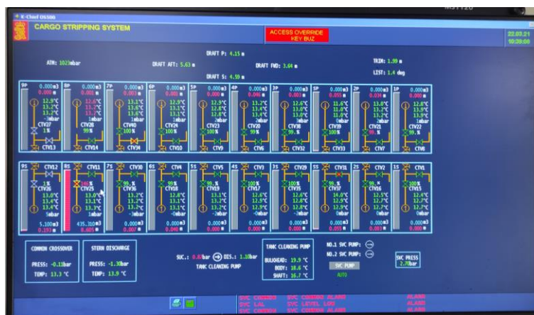
Ilustración 28. Pantalla de control de válvulas de los tanques de carga. Fuente: Trabajo de campo.
