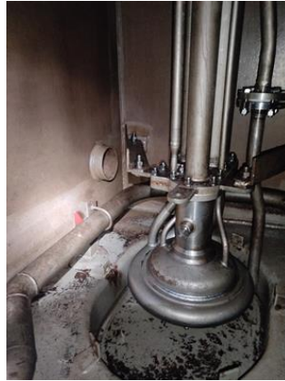
Ilustración 19. Aspiración de la bomba. Fuente: Trabajo de campo.
