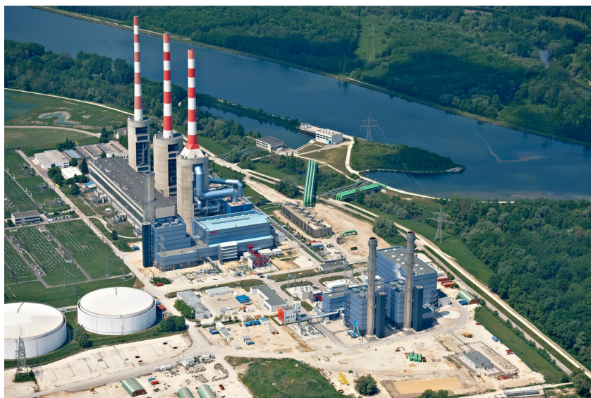
Imagen 2. 10: Perspectiva aérea de la central de ciclo combinado SCC5 -8000H 1S. Fuente: Siemens
