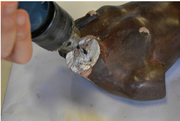
Ilustración 46. Taladrado sobre RH1 para el acople del perno que unirá con la cabeza (RH2).
