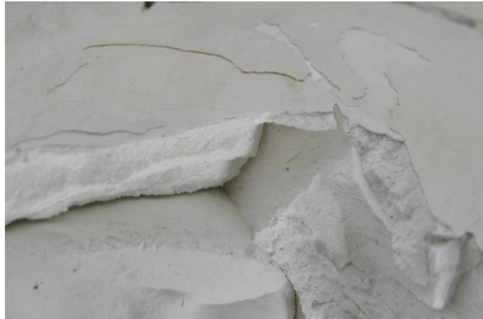
Ilustración 57. Fina capa superficial que se evidencia por sus levantamientos, así como en las zonas de rotura donde también se aprecian las diversas coladas.
