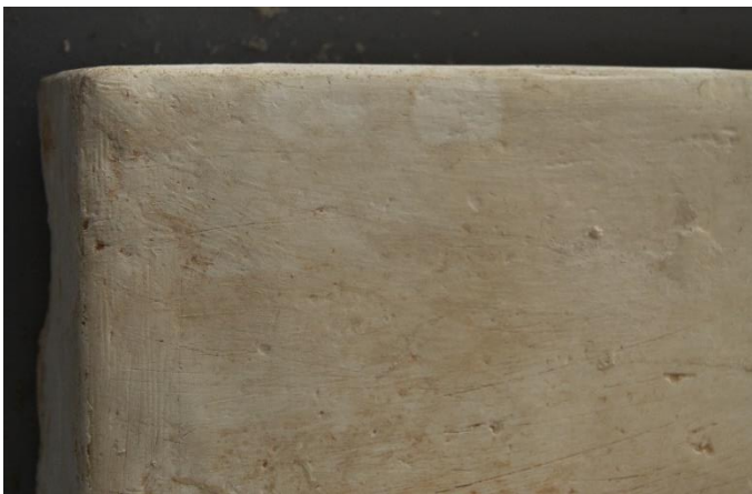
Ilustración 5. Resultado de la retirada de las 3 muestras sobre la base de RV1 donde se comprueba la efectividad de la mezcla al 8%.
