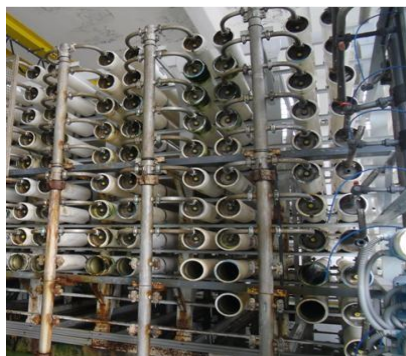
Ilustración 68: Vista frontal de un bastidor, zona de alta presión
