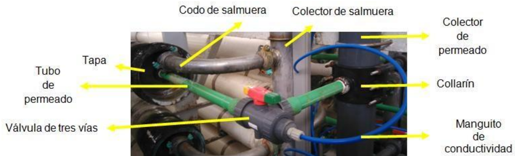
Ilustración 72: Parte de baja presión del bastidor
