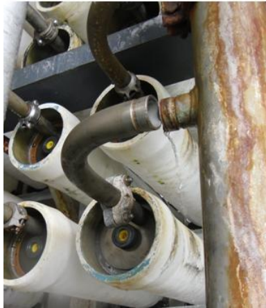
Ilustración 75: Retirada de la tapa de alta presión
