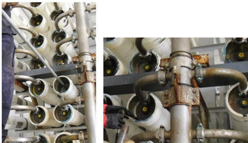
Ilustración 79: Empujando membranas y montando tapa de alta presión
