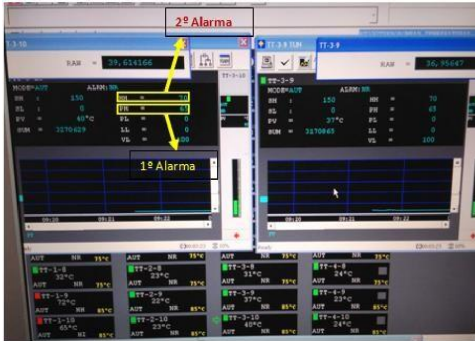
Ilustración 131: Alarmas a tener en cuenta cuando se engrasa la turbina, 1º a 65°C y la 2º a 70°C
