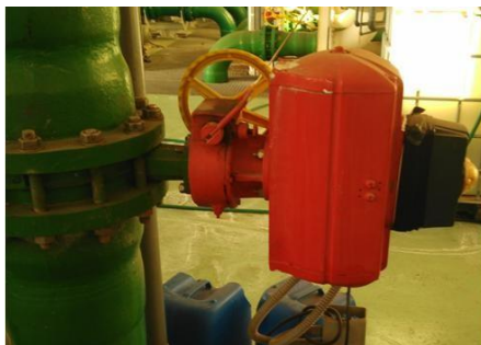
Ilustración 31. Válvula VC-01 con su actuador neumático
