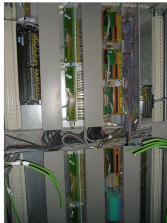
Ilustración 143: Armario de tarjetas de entradas y salidas analógicas y digitales
