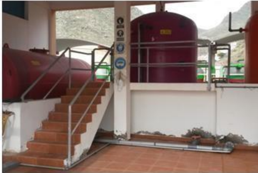
Ilustración 16. Depósitos de ácido sulfúrico y coagulante.
