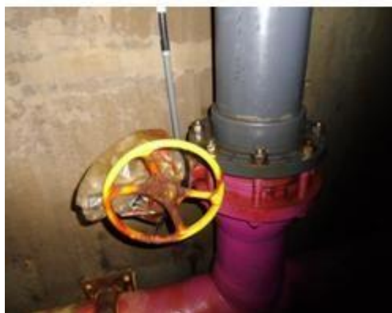
Ilustración 37. Válvula manual de la salmuera
