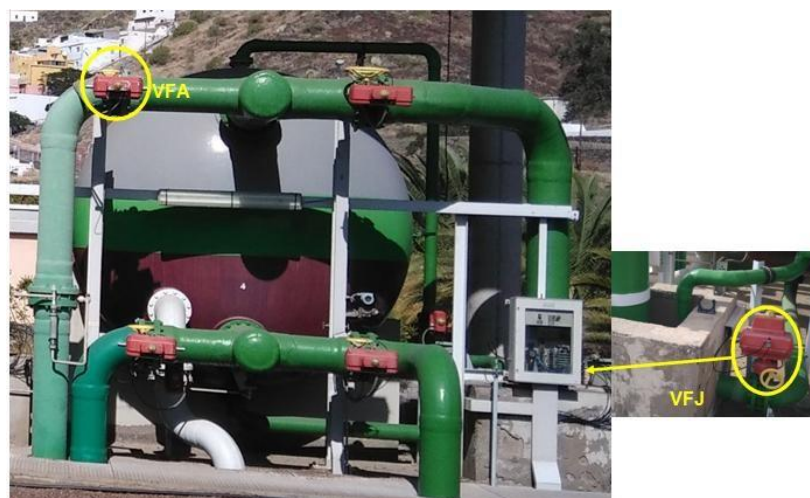
Ilustración 67: Vista frontal y válvulas que actúan en un filtro de arena de 2ª etapa
