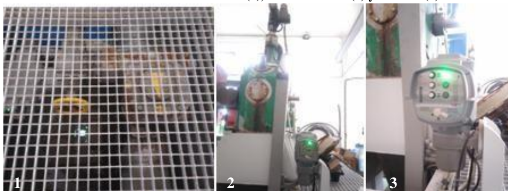
Ilustración 39. Válvula VC-03 (1), válvula VC-04 (2) y selector (3)
