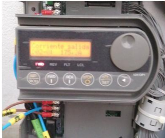
Ilustración 146: Indicación de que la intensidad está a 175 A
