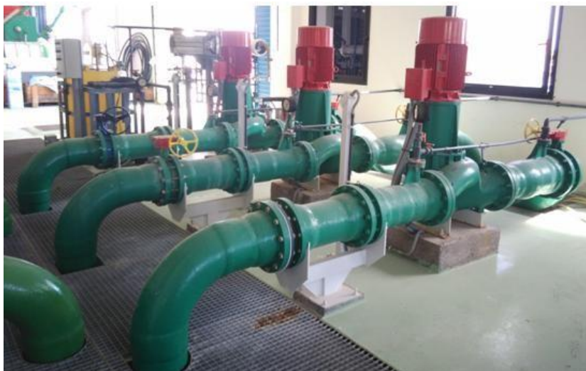
Ilustración 50: Bombas de limpieza con salmuera
