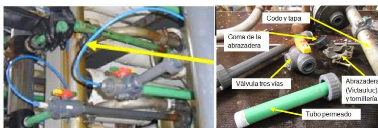
Ilustración 74: Desmontaje de diferentes piezas
