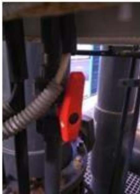
Ilustración 47. Válvula de venteo
