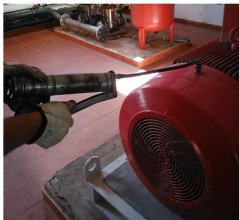
Ilustración 132: Engrasando motor eléctrico de bombas de ciudad
