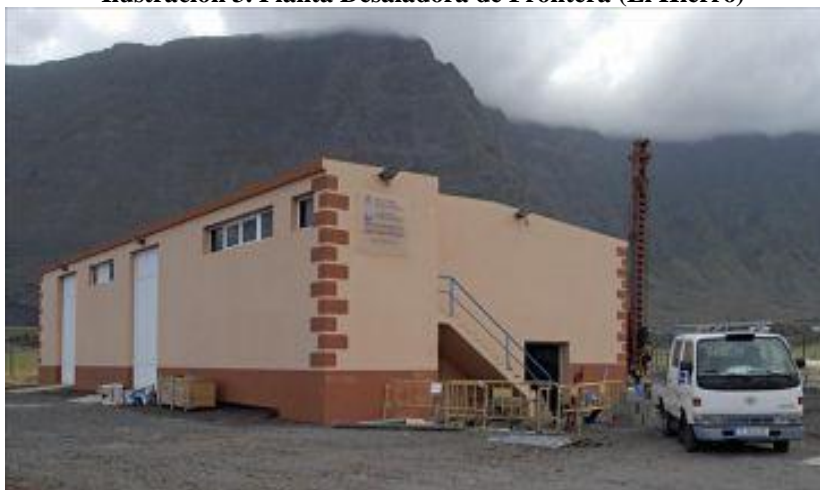
Ilustración 3. Planta Desaladora de Frontera (El Hierro)
