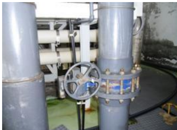
Ilustración 38. Válvula manual de permeado
