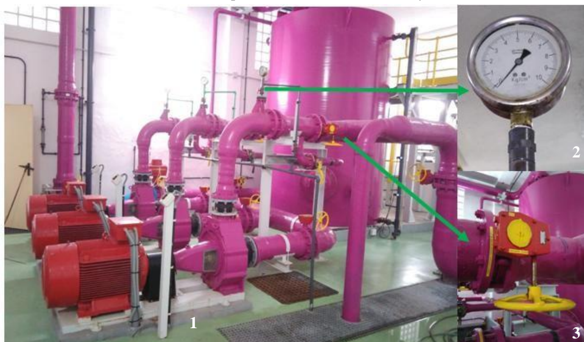
Ilustración 44. Bombas de desplazamiento (1), manómetro (2) y válvula manual (3)
