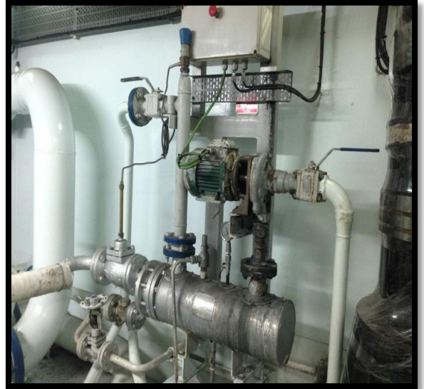
Imagen 36: Pre-calentador de agua MM.PP
