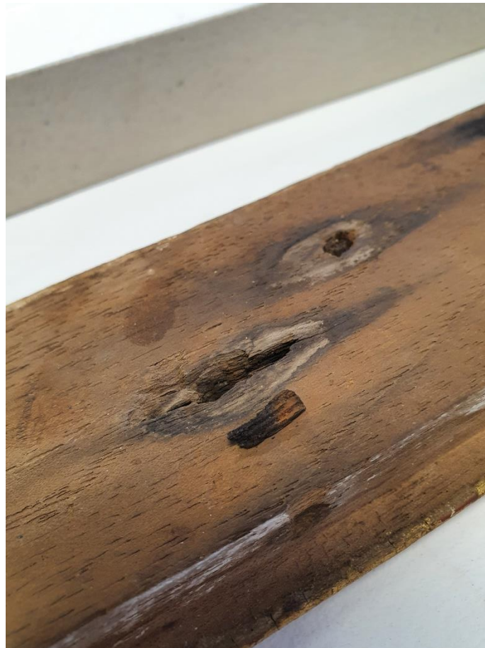
Ilustración 88.- Detalle de una lasca apunto de soltarse. No era necesario su consolidación, por lo que se decidió desecharlo.
