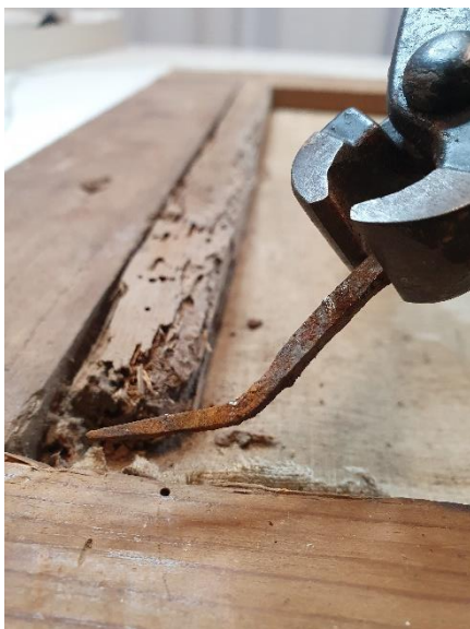
Ilustración 83.- Eliminación de clavos de larguero inferior.
