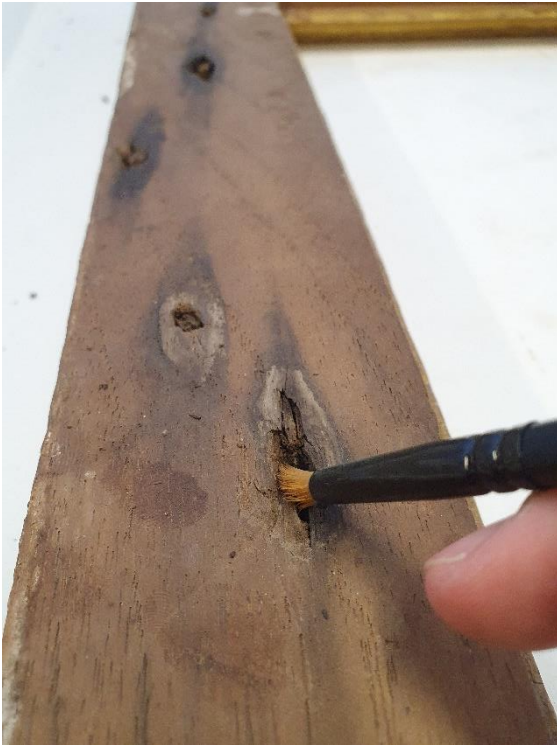
Ilustración 86.- Eliminación de suciedad y telas de araña de los huecos de la trasera del marco.
