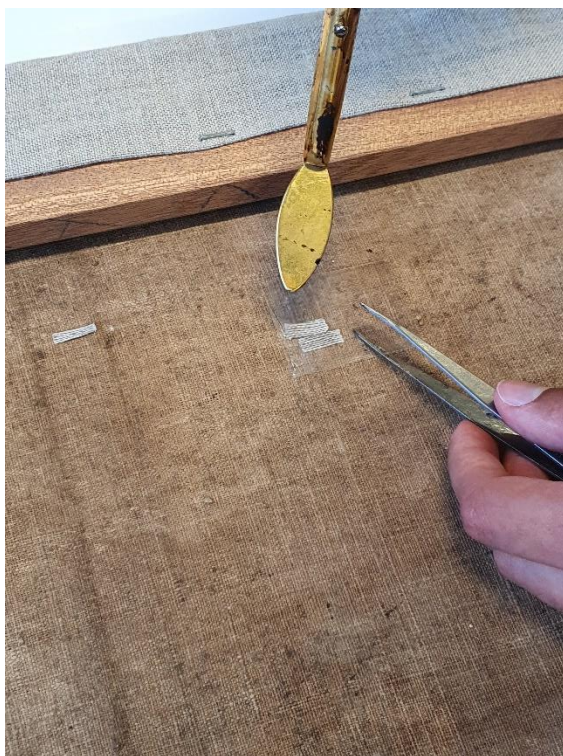
Ilustración 153.- Colocación de grapas de lino con Beva Film*
