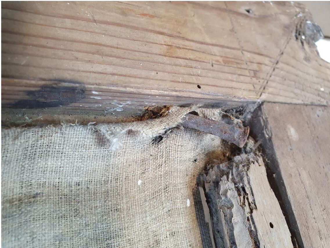
Ilustración 97.- Detalle de clavo de la parte inferior. Se Puede ver con detalle la suciedad y el estado en el que se encontraba. Además de cómo se agarraba la tela al marco por la falta de ese larguero.
