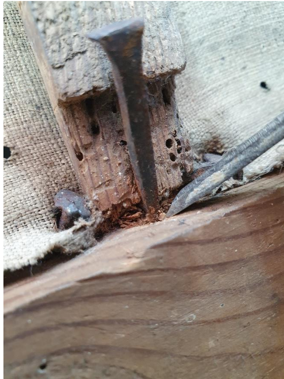
Ilustración 82.- Proceso de separación del desmontaje. Extracción de clavos del travesaño.
