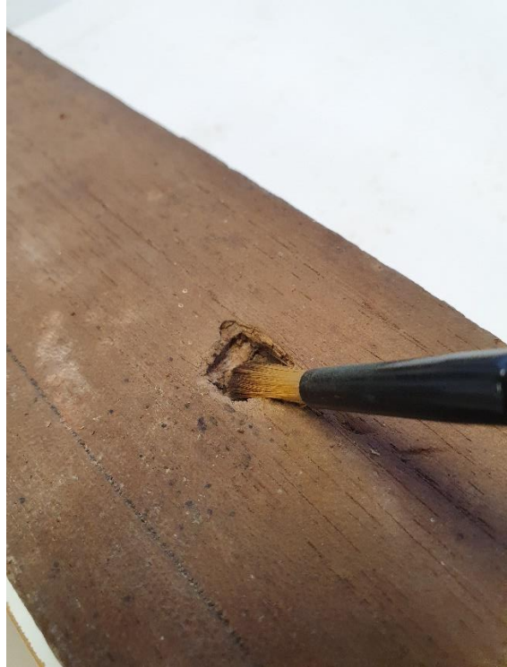
Ilustración 87.- Limpieza del polvo y telas de arañas.
