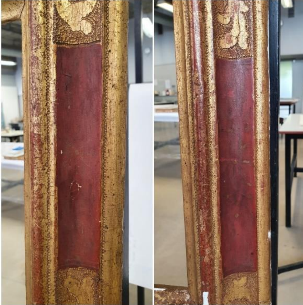
Ilustración 81.- Oxidación de la capa de protección. Detalle de la pérdida de la decoración del larguero derecho.
