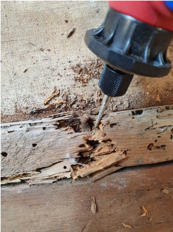
Ilustración 94.- Extracción del clavo inferior del bastidor. Para esta parte fue necesario usar la dremmel, ya que no se alcanzaba a ver el clavo.
