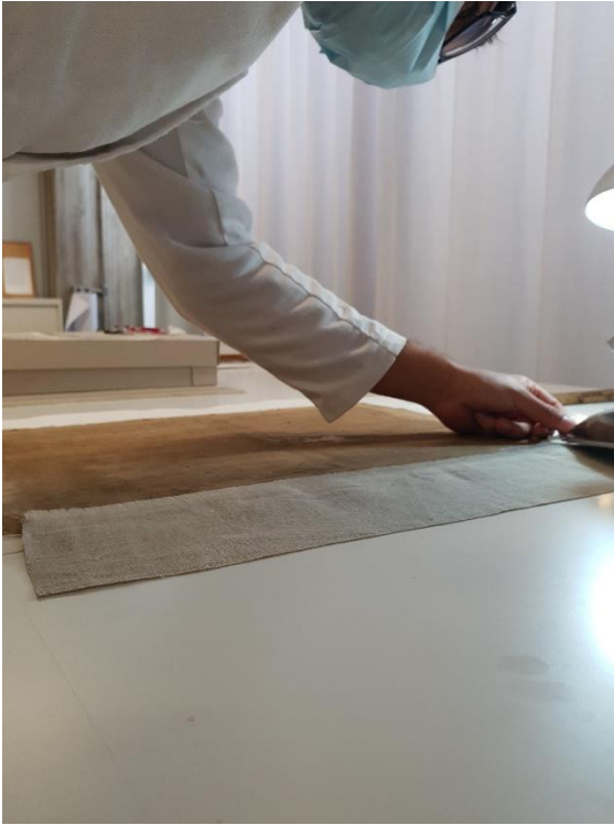
Ilustración 149.- Adición de las bandas perimetrales con calor.
