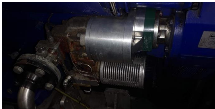
Ilustración 96: Motor de Arranque. Fuente: Trabajo de Campo.
