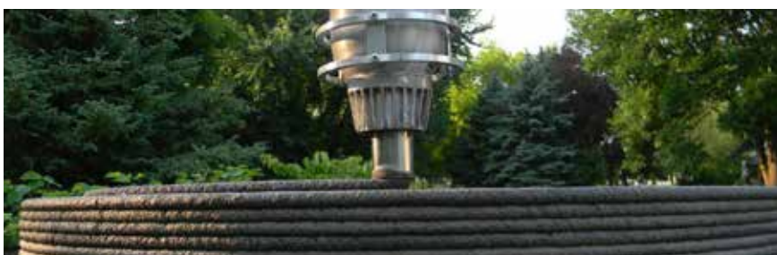
Fig. 2, Impresora de hormigón
