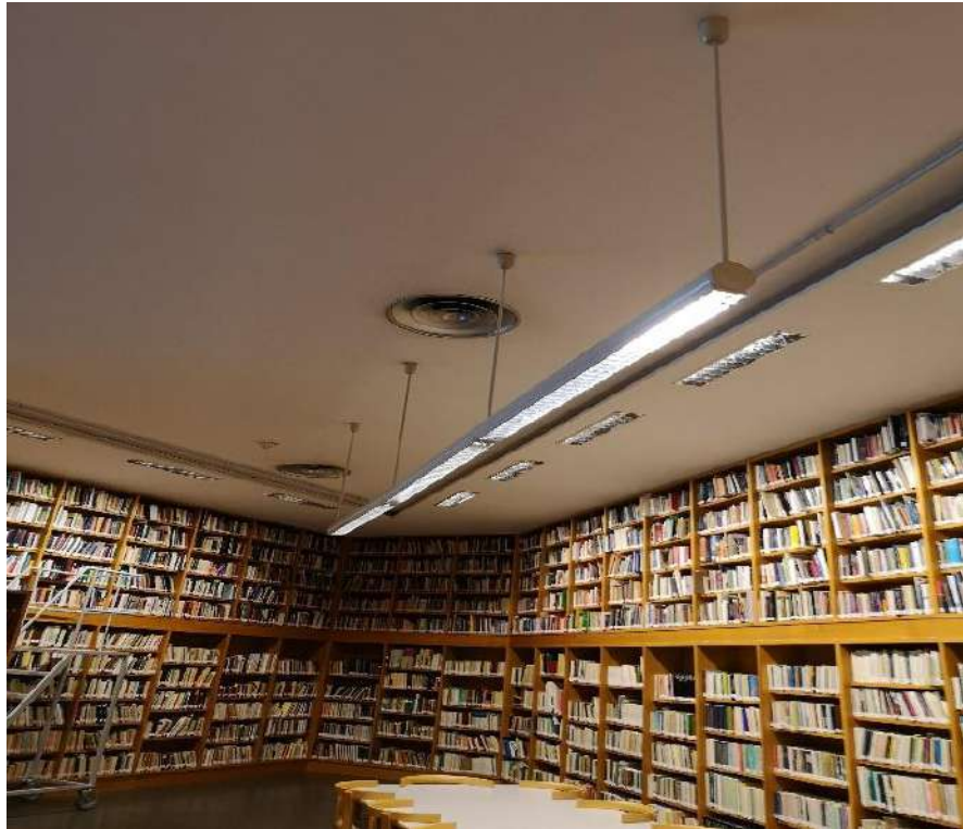
Figura 34. Luminarias OSRAM L58W/830 Lumilux Warm White en Biblioteca de Canarias.
