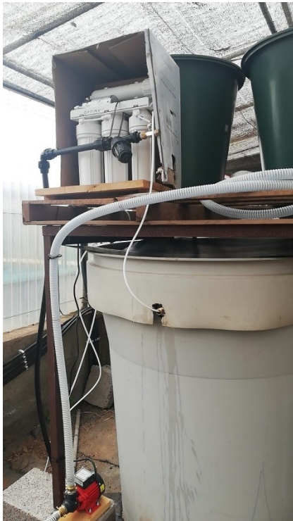
Imagen 4.8. Planta ósmosis inversa
