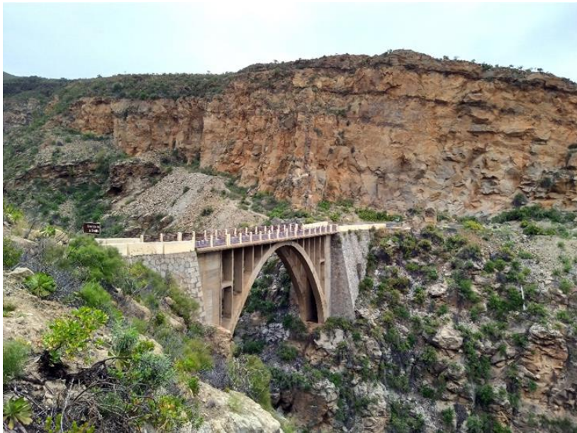
Fig.22. Puente de la carretera que va al Charco del Pino
