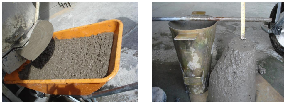
Figura AII.6. -Descarga del hormigón y realización del cono de Abrams.
