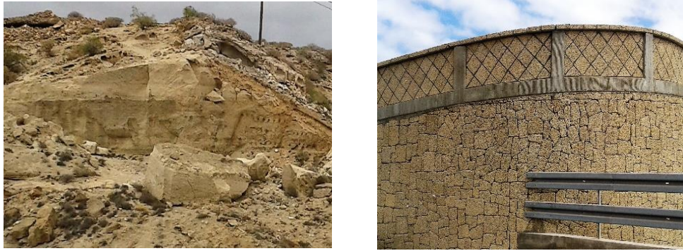
Figura 3.4.- Imagen de corte de puzolana de toba (izquierda) y uso de aplacado decorativo de la toba (derecha).
