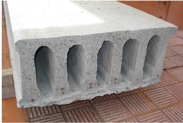
Figura 2.2.- Imagen de una placa de hormigón armado.
