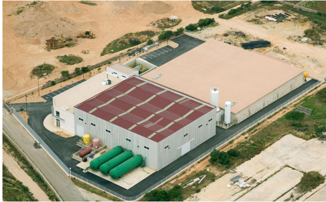
Figura 14. Vista general de les instal·lacions de la dessalinitzadora de Ciutadella, a Menorca
