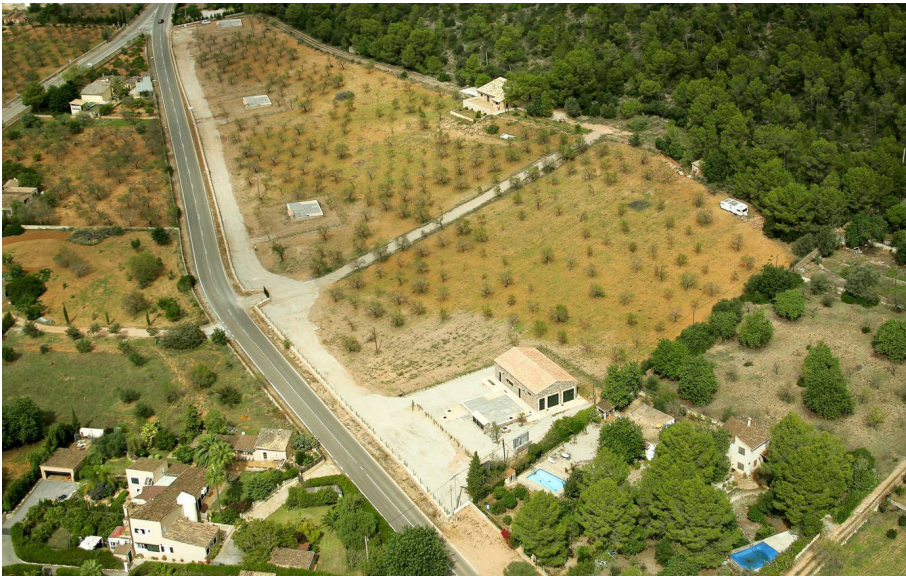
Figura 26. Vista aèria de la localització del bombament de s'Estremera, a Mallorca
