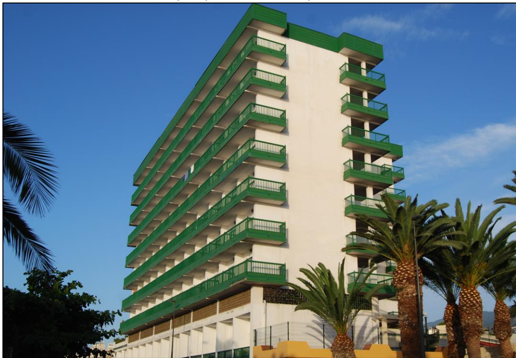
Imagen 20. Resultado de la fachada lateral del H. Puerto Playa con sustitución de balcones de madera y carpintería exterior por aluminio lacado (2000)
