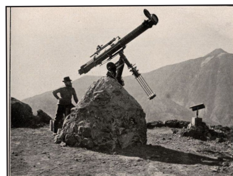
FIG. 198. — En vue du Pic de Teyde, sur le Guajara : nouveau pilier en ciment armé, pour l'équatorial.
