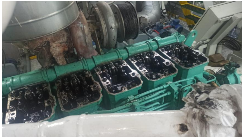
Ilustración 89. Desmontaje del Motor Auxiliar. Fuente: Trabajo de Campo
