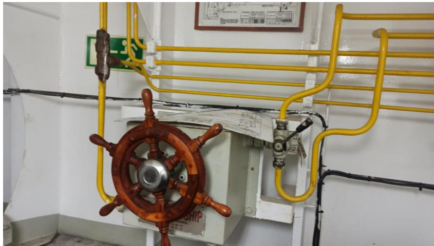
Ilustración 34. Timón de Emergencia. Fuente: Trabajo de Campo
