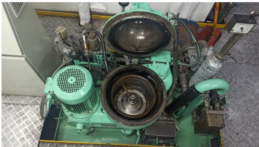
Ilustración 63. Desarme Depuradora. Fuente: Trabajo de Campo
