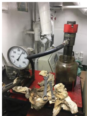
Ilustración 57. Prueba de Inyección. Fuente: Trabajo de Campo
