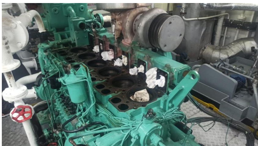
Ilustración 90. Desmontaje del Motor Auxiliar. Fuente: Trabajo de Campo
