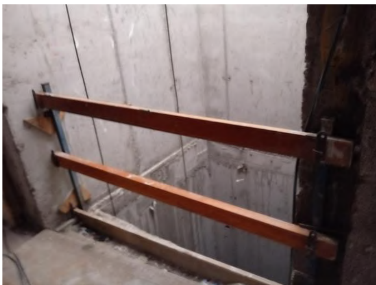
Fig 60 Vallado de hueco de ascensor Fuente:propia
