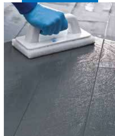
Limpieza de las juntas con Scotch-Brite® (con el producto parcialmente endurecido)
