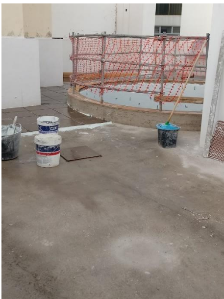
Fig 52 Vallado metálico Fuente:propia
