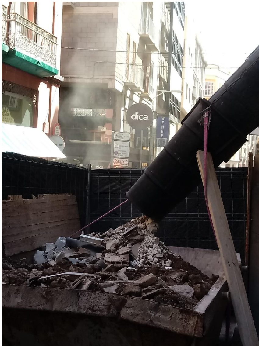
Fig 1 Vertido de escombros en el contenedor
