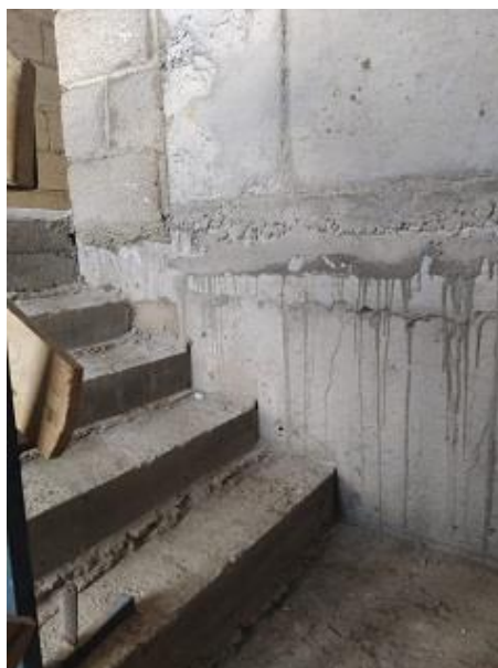
Fig 3 Recorrido de la escalera a planta 4
