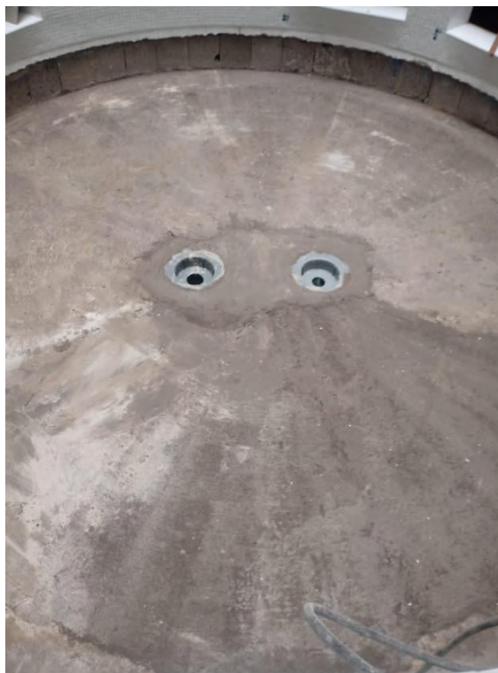
Fig 25 Patio interior sin impermeabilización.
