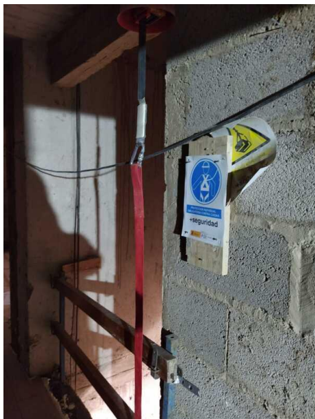
Fig 49 Sistema de anclaje para las operaciones junto a hueco de ascensor Fuente:propia
