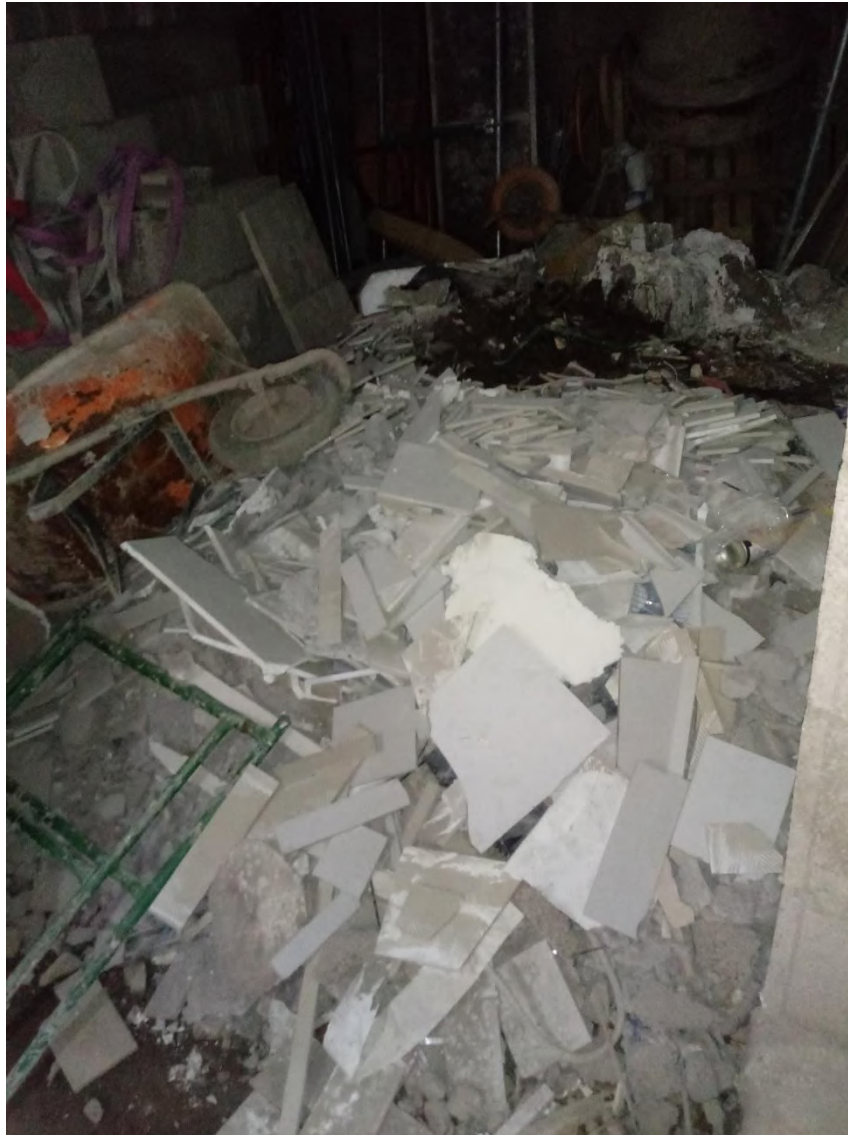
Fig 4 Almacenaje de residuos en la planta baja junto a acopios de material y maquinaria de trabajo. Fuente: propia
