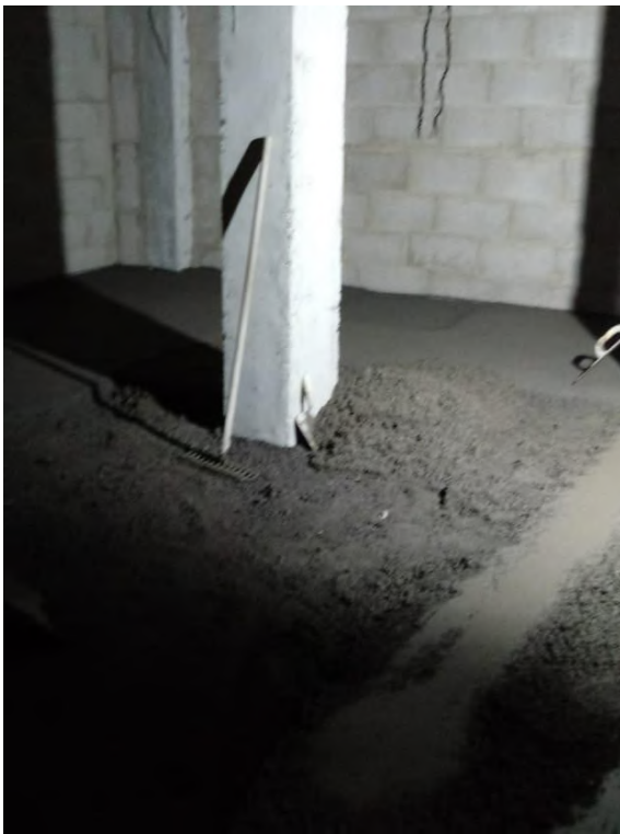
Fig 12 ejecución de un atezado Fuente:propia
