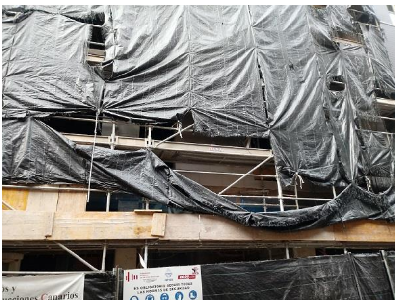
Fig 32 Fachada cubierta mientras se realizan los trabajos de enfoscado y revestido.
