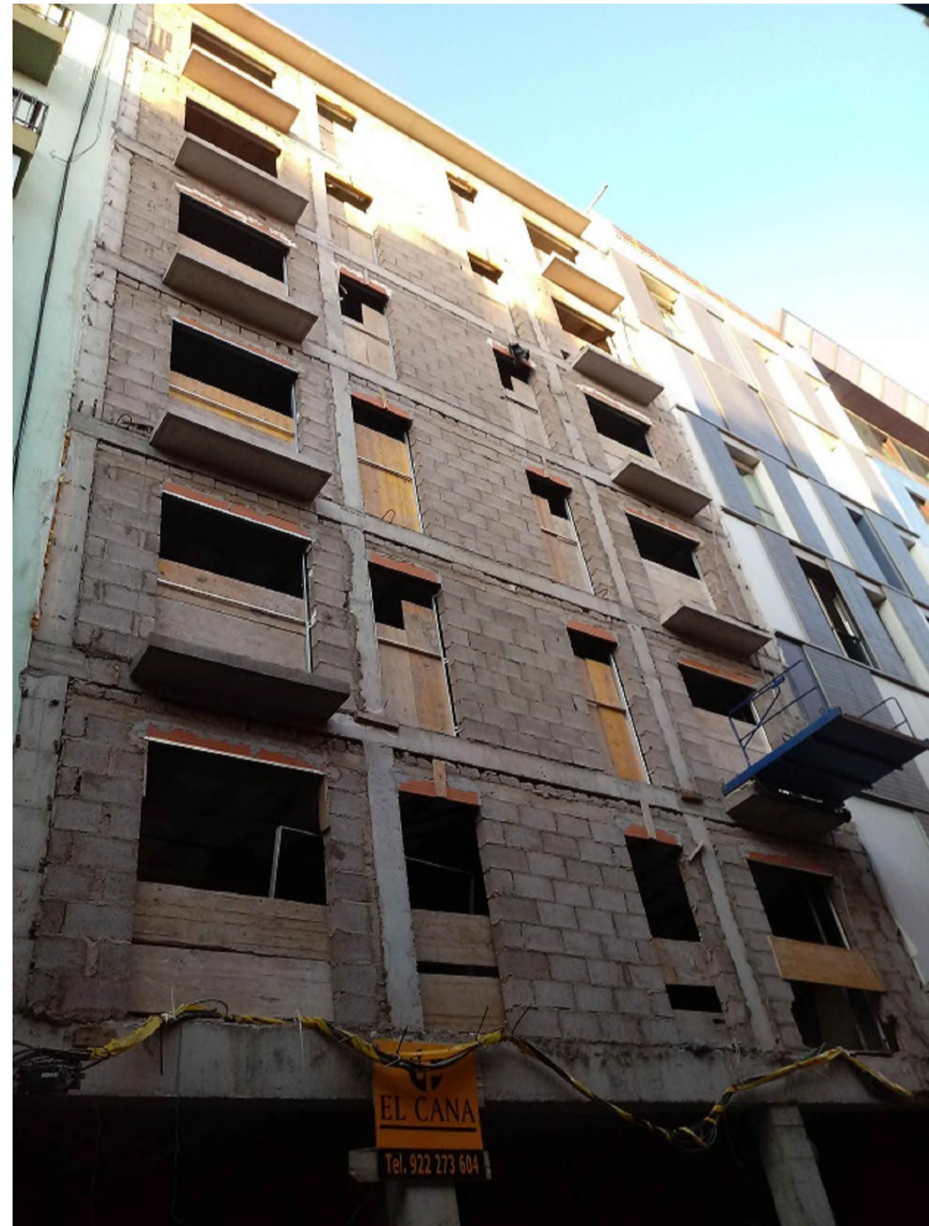
FACHADA NORTE CON CERRAMIENTO EXTERIOR
