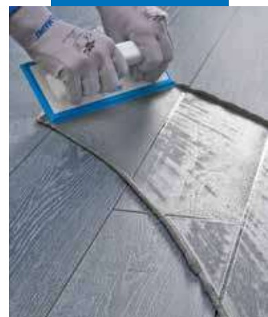
Aplicación de Ultracolor Plus en pavimento con llana de goma, sobre baldosas de gres porcelánico efecto madera
