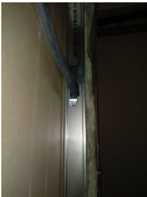
Fig 28 Paso de instalaciones por un montante colocado correctamente
