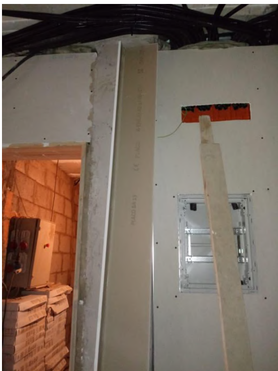
Fig 39 Revestimiento de pilar con PYL BA13
