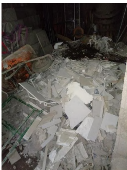
Fig 62 Almacenaje de residuos en zonas no especificadas para este fin Fuente:Propia
