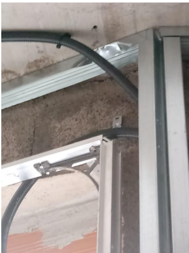
Fig 30 Perfil aplastado para pasar instalaciones
