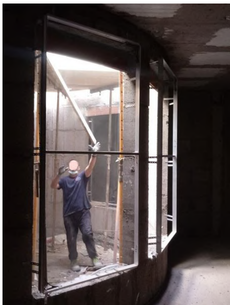
Fig 48 Operario cargando materiales bajo el andamio del patio interior Fuente:propia
