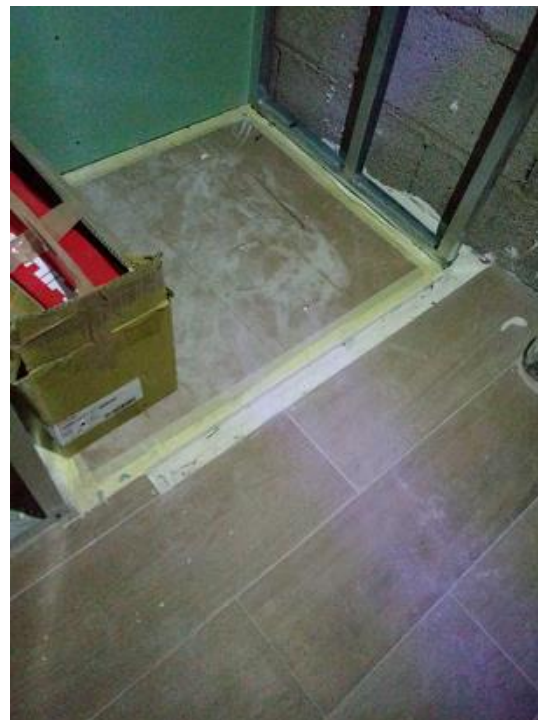
Fig 10 Plato de Ducha instalado y protegido.
