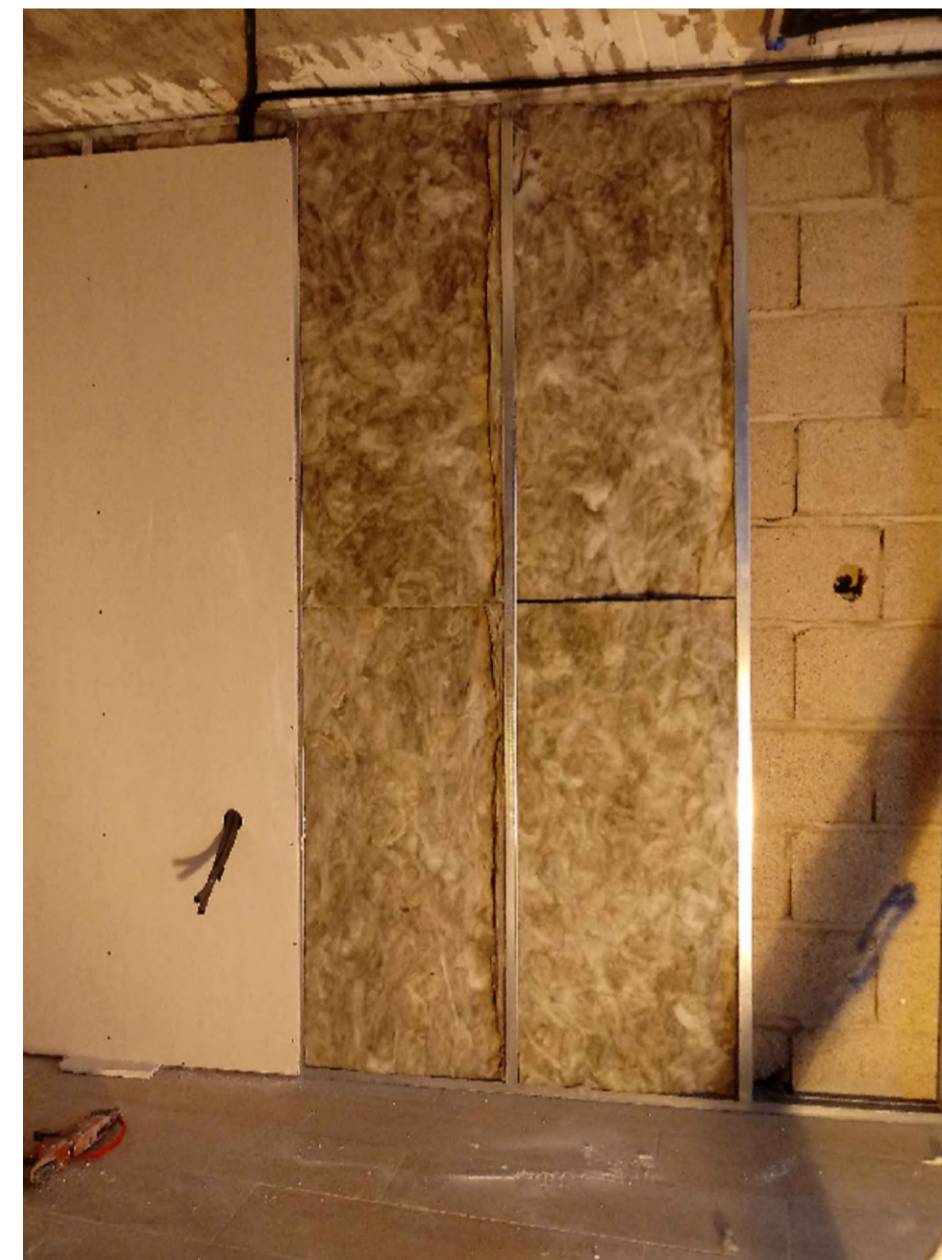
COLOCACION TABIQUERIA SECA PLACO BA
