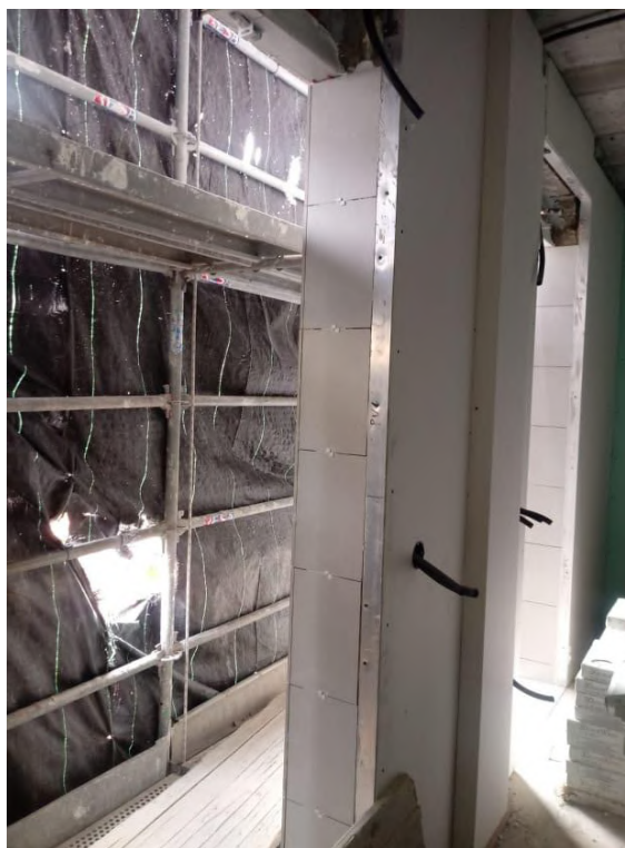
Fig 34 Revestimiento cerámico con grapa vista
