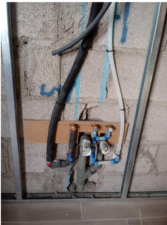
Fig 13 Puntos singulares, Codos Fuente:propia
