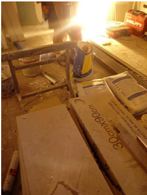
Fig 61 Zona abarrotada con acopios de cerámica y estación de trabajo PYL Fuente:propia
