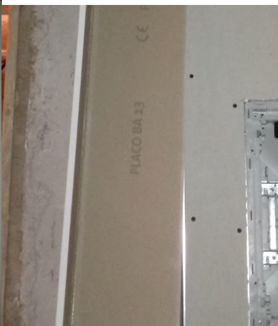
Fig 40 Ampliación del revestimiento de pilar
