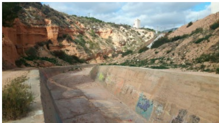
Figura 8. Canal trapezoidal de hormigón armado. Parte inicial del encauzamiento de la rambla del Castellar.
