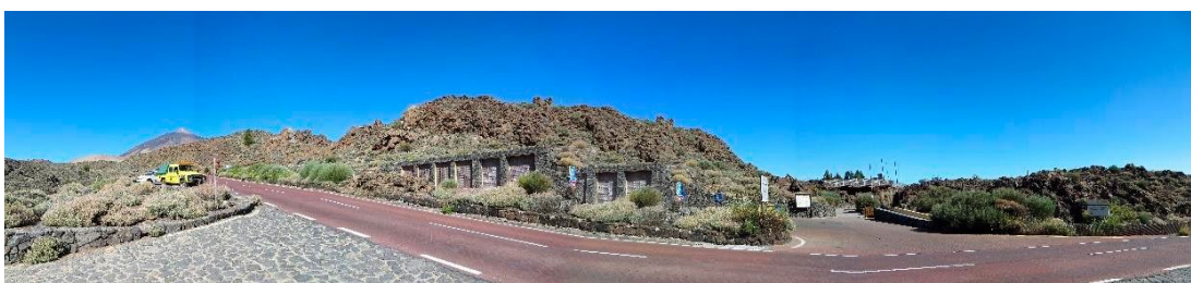
Imagen7. Vista de los paneles fotovoltaicos situados en el centro de visitantes
