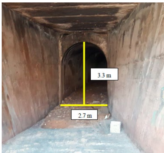
Figura 10. Medidas de la segunda entrada de la canalización.
