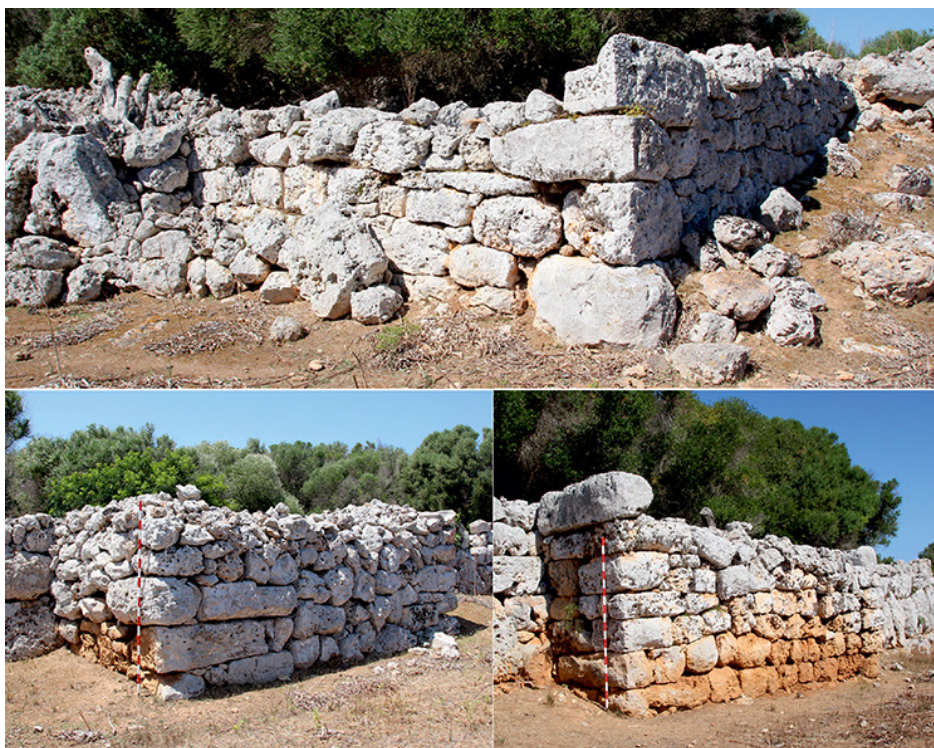
Figura 6. Esquina sureste del recinto fortificado de Son Catlar, donde se observan sillares almohadillados dispuestos a sago y tizón (arriba); y bastiones adosados este y norte del citado poblado menorquín (cortesía de Proyecto Modular).
