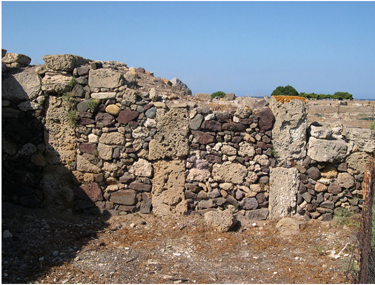
Figura 3. Aparejo a telaio o muro de pilares en vivienda de Nora (Cerdeña) (cortesía de F. Prados Martínez).
