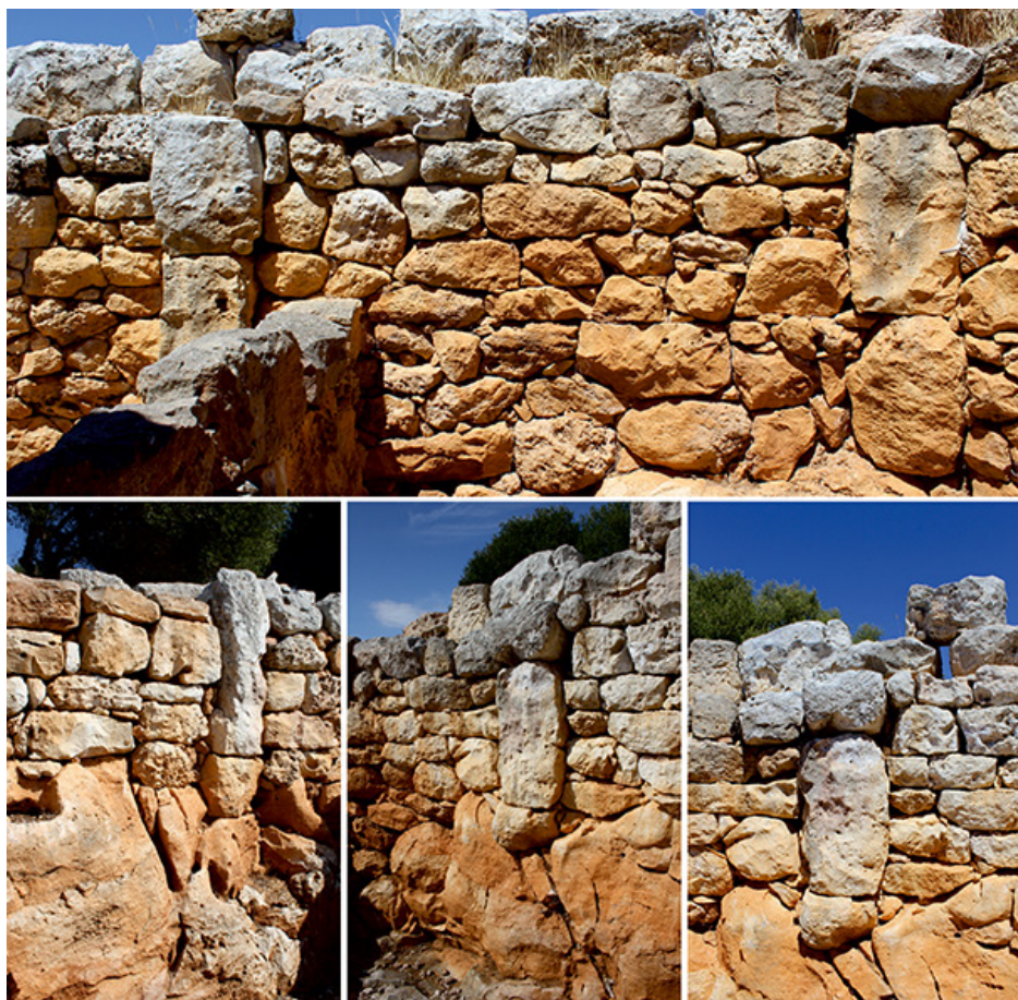
Figura 8. Aparejo de pilares en los paramentos interiores de las viviendas de Torre d'en Galmés.
