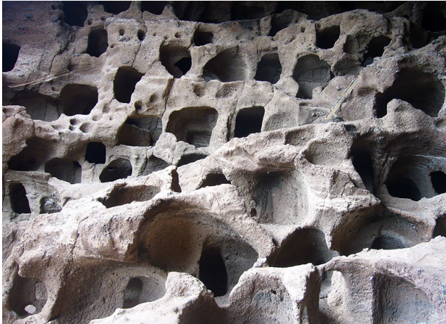
Figura 11. Vista parcial del granero de Valerón, Guía.
