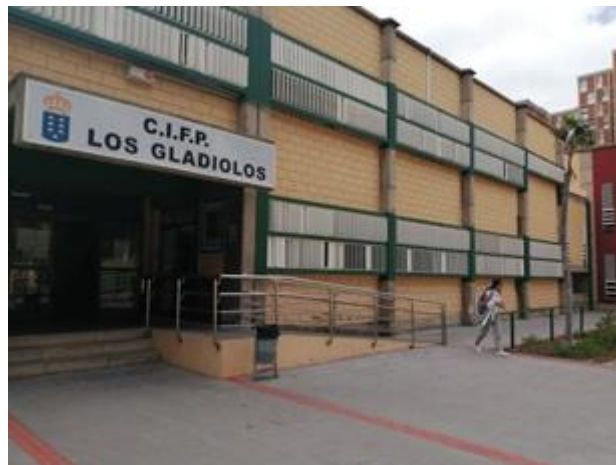
Figura 2. Localización de la entrada al hall del CIFP Los Gladiolos
