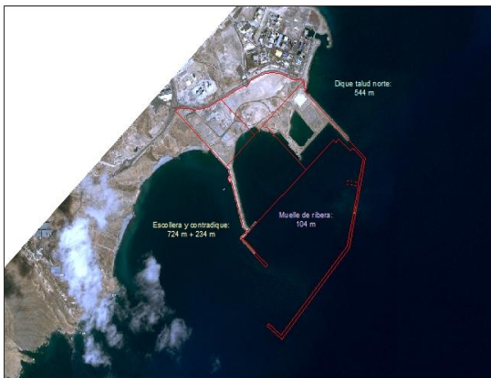
5. Fecha de toma: 22 de septiembre de 2014. Se fondean los primeros cajones de hormigón de la obra del dique de abrigo y se continúa poniendo cajones en la prolongación en el dique vertical
