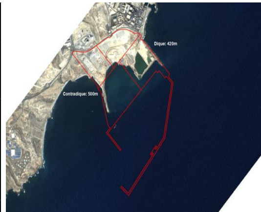
4. Fecha de toma: 14 de septiembre de 2012. Se colocan en el contradique 7 cajones de hormigón y se inicia el acopio provisional de 6000 m 3 de arena de dragado para el trasvase norte-sur
