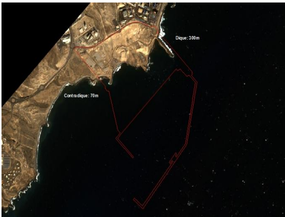
3. Fecha de toma: 20 de diciembre de 2011. Trabajos terrestres de preparación, acomodación y nivelación del terreno. Se inician los trabajos en el mar para lo que será el futuro dique de abrigo y el contradique
