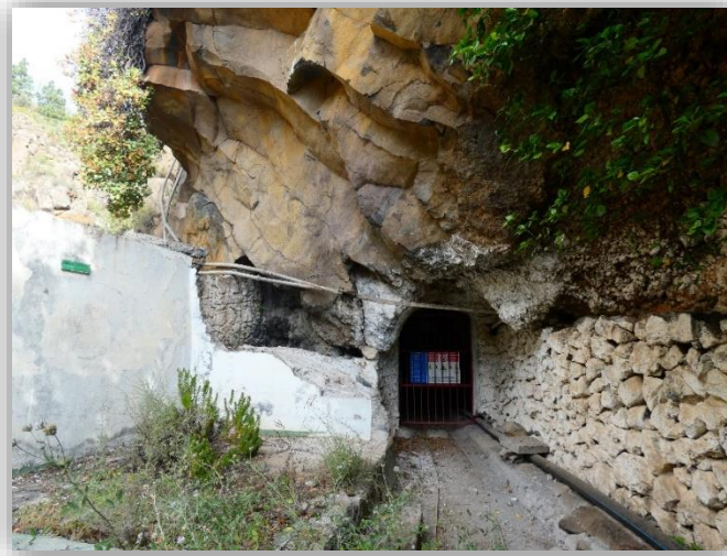
Figura 2: Bocamina de la Galería del Lomo Cambado. Barranco de Añavingo, Arafo. Fuente: Laura Fariña.
