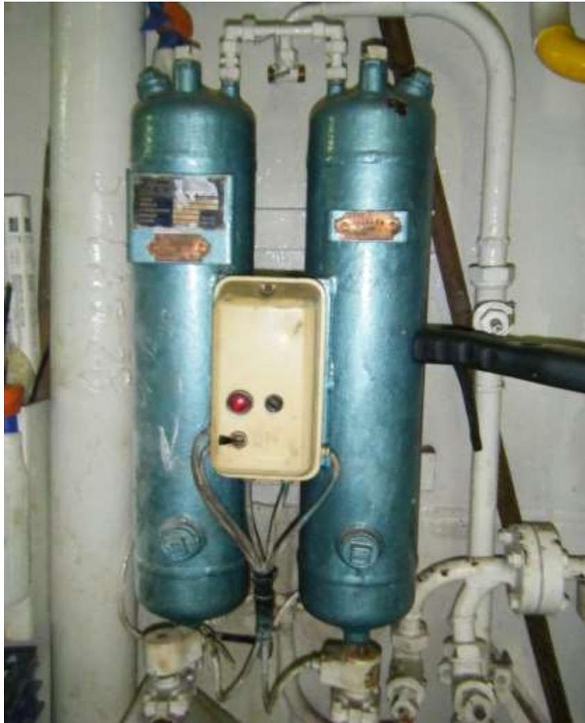
*Ilustración 30. Secador de aire. Fuente: Elaboración propia.*
