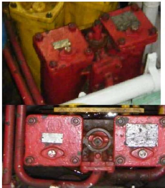
*Ilustración 14. Filtro dúplex de combustible. Fuente: Elaboración propia.*
