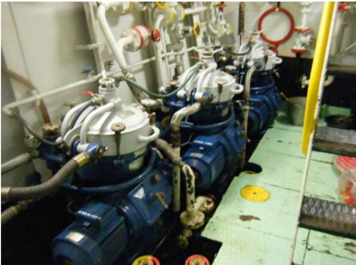
*Ilustración 2. Depuradoras Alfa Laval MAB 204S. Fuente: Elaboración propia.*
