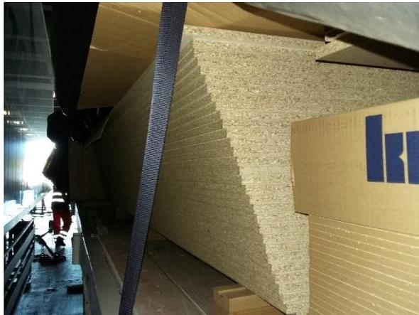
*Fig. 28: Corrimiento de carga previo al embarque*
