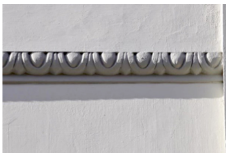
Figura 1. Moldura en ovario del edificio n.º 57 de la avenida Ángel Guimerá de Santa Cruz de Tenerife. Foto: el autor.
